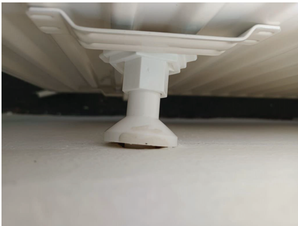
Obr. 2 - kotvení radiátoru – samovolné vytrhávání kotvy detail (mechanické kotvení)
