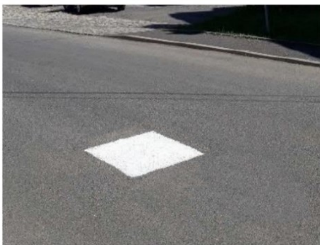
Obr. 3: Rozměry a tvar signalizace SVB nátěrem na zpevněné kontrastní ploše
