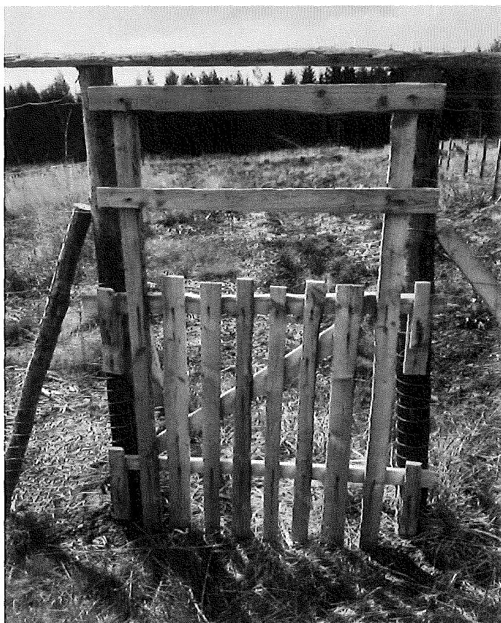
Dřevěná branka z latí (ráhen) výšky 160 cm. Podélně umístění prvků (vytaženo k zemi) ve výšce cca 30, 100, 130 a 160 cm. Svislé prvky maximální mezera 5 cm. Zpevnění příčnou latí (ráhnem) mezi cca 30 a 100 cm od země. Uchycení pomocí čtyř zahnutých hřebíků případně dřevěných zámků (viz obr. výše) přichycených hřebíky (případně vruty – ocelové sloupky).
