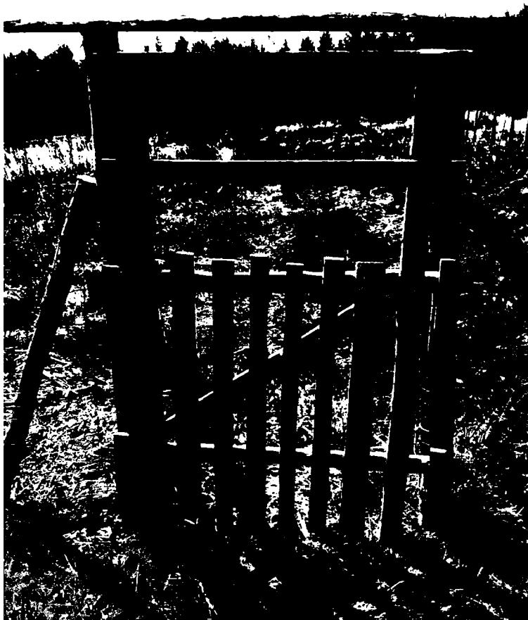
Dřevěná branka z latí (ráhen) výšky 160 cm. Podélně umístění prvků (vztaženo k zemi) ve výšce cca 30, 100, 130 a 160 cm. Svislé prvky maximální mezera 5 cm. Zpevnění příčnou latí (ráhnem) mezi cca 30 a 100 cm od země. Uchycení pomocí čtyř zahnutých hřebíků případně dřevěných zámků (viz obr. výše) přichycených hřebíky (případně vruty – ocelové sloupky).
