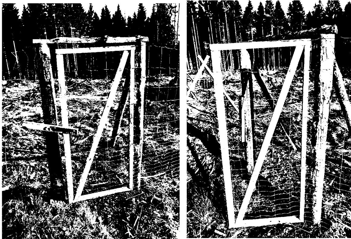
Pletivo přibité na dřevěný rám (lať, přířezy, krajinky). Zajištění proti samovolnému otevření z venkovní strany pomocí dřevěného kolíku umístěném ve středu kůlu (sloupku) prostřednictvím hřebíku (vrutu). Samovolné otevření do prostoru oplocenky je zajištěno zarážkou (kolíkem) o průměru min. 7 cm a délce min. 50 cm, jež je zatlučen v rostlé zemi min. 40 cm.
