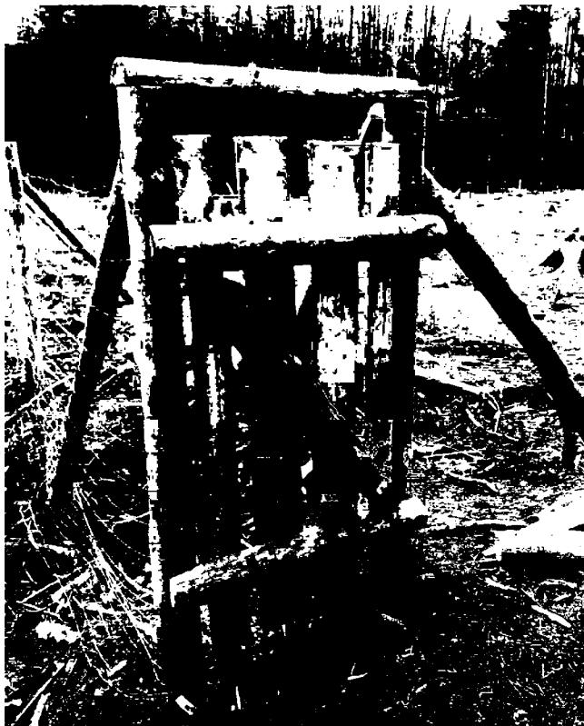
Dřevěná branka z latí (ráhen) výšky 160 cm. Podélně umístění prvků (vztaženo k zemi) ve výšce cca 30 a 140 cm. Svislé prvky maximální mezera 5 cm. Zpevnění přičenou latí (ráhnem) mezi cca 30 a 140 cm od země. Uchycení pomocí čtyř zahnutých hřebíků.
