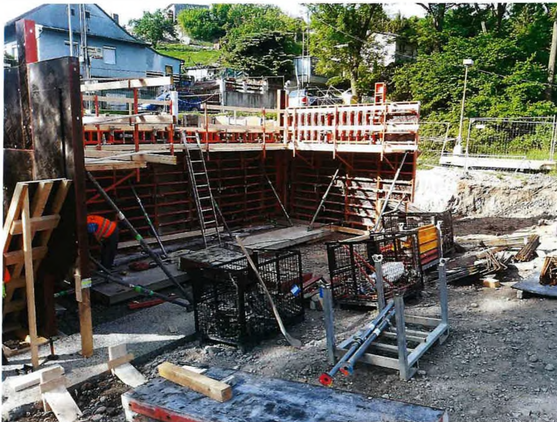
SO 201 MOST – montáž bednění a armatury
