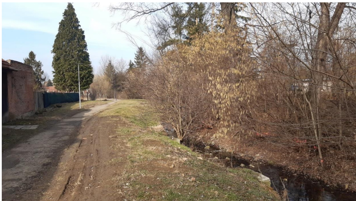
Obr. č. 1: Intravilán Koryčany - pohled na koryto toku v ř. km 1,3. Reflexním sprejem označeny dřeviny a křoviny k odstranění.
