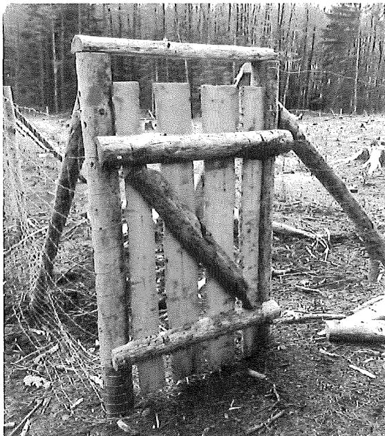
Dřevěná branka z latí (ráhen) výšky 160 cm. Podélně umístění prvků (vztaženo k zemi) ve výšce cca 30 a 140 cm. Svislé prvky maximální mezera 5 cm. Zpevnění příčnou latí (ráhnem) mezi cca 30 a 140 cm od země. Uchytení pomocí čtyř zahnutých hřebíků.
