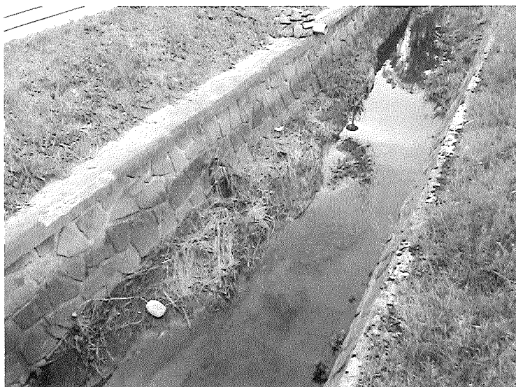
pohled do koryta vodního toku s minimálním množstvím sedimentů
