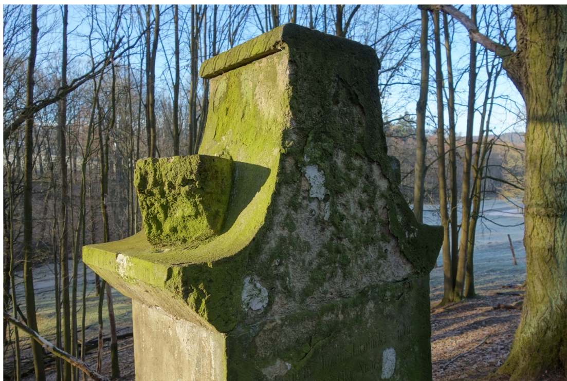
Obr. 5: Detailní pohled na zadní zerodovanou plochu hlavice. Stav 24.2.2022.
