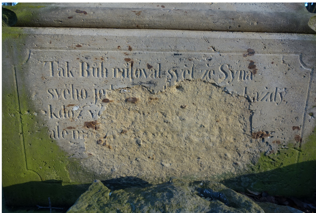
Obr. 7: Detailní pohled na zerodovaný text v čelní ploše podstavce. Stav 24.2.2022.
