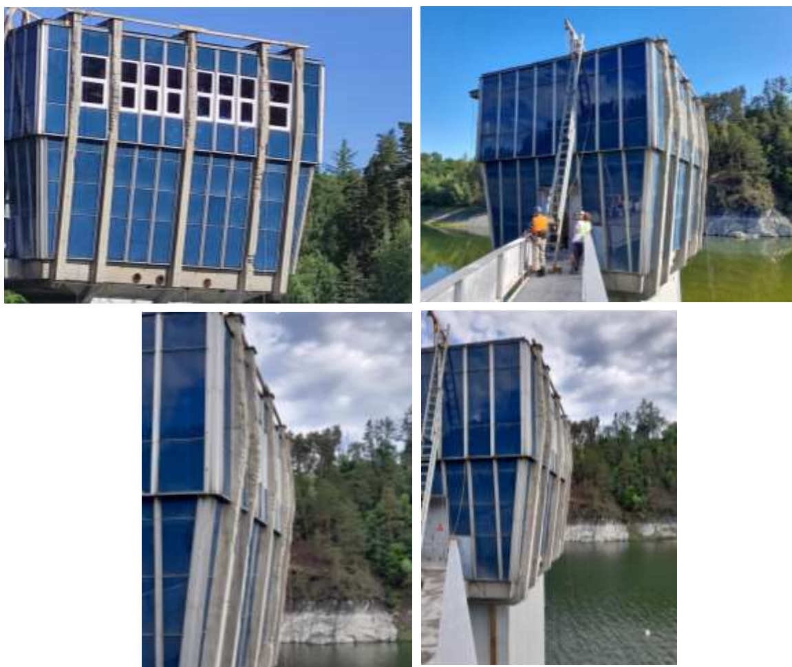
Poškození žeber na odběrné věži VD Letovice
