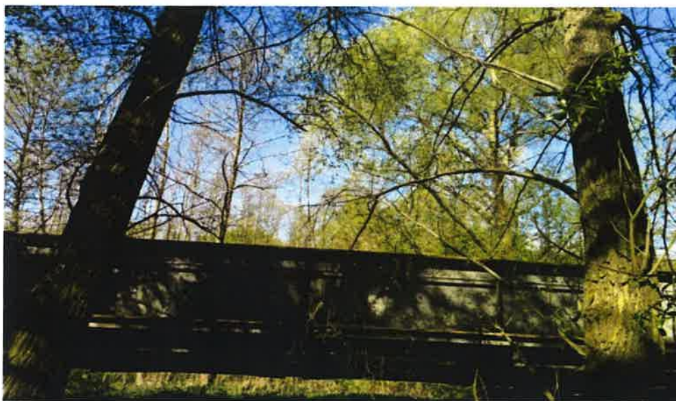
Úsek č. 2 - vrby bílé v bezprostřední blízkosti železničního mostu v ř.km 18,800
