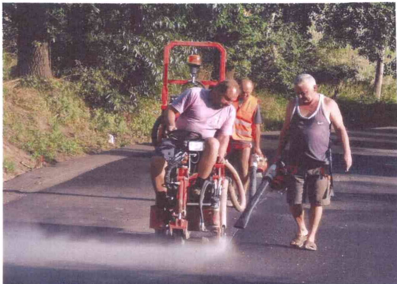
prořez a čištění spáry v obru (1. úsek)
