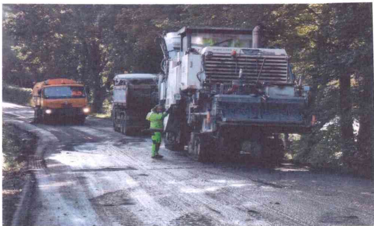
frézování asf. souvrství
