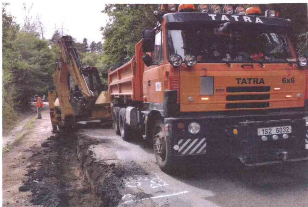
odkop krajnice (2. úsek)
