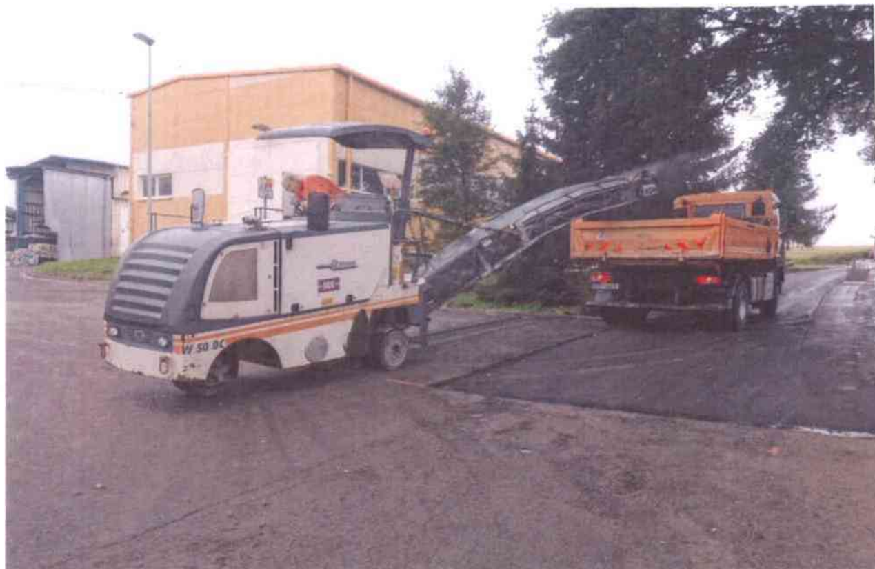
frézování vjezdu na skládku s odvozem na 1. úseku
