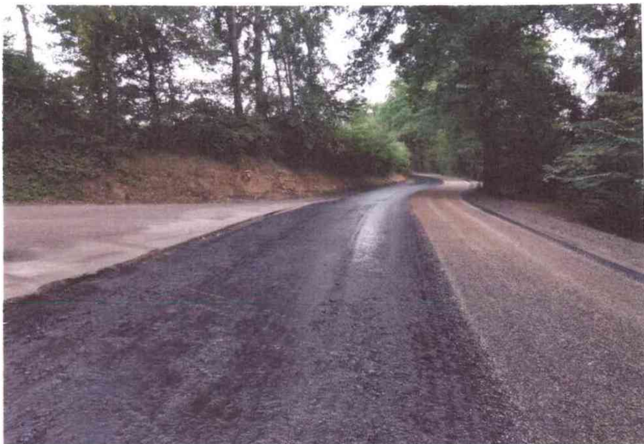
provádění spoj. postřiku
