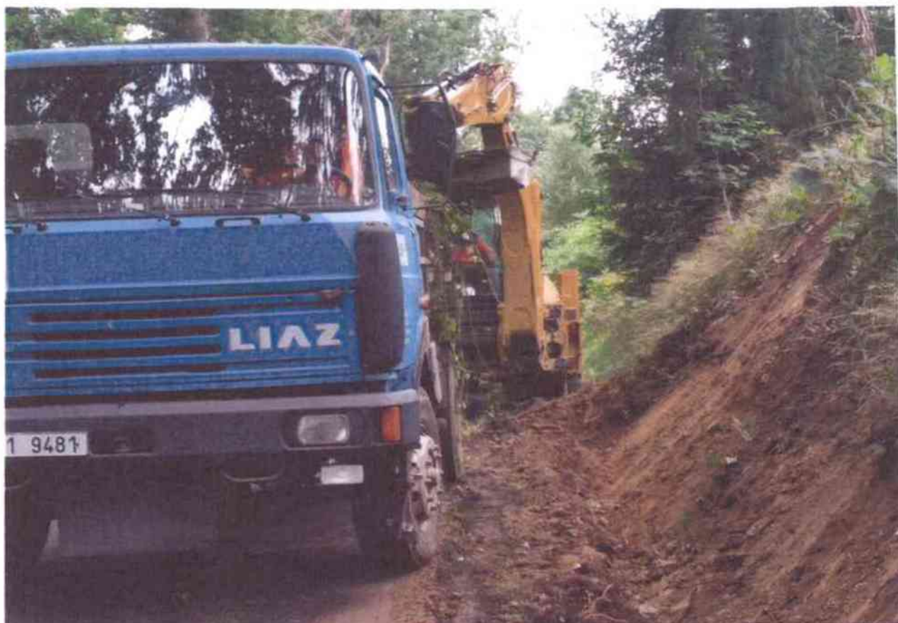
strojný úprava svahu vlevo (2. úsek)
