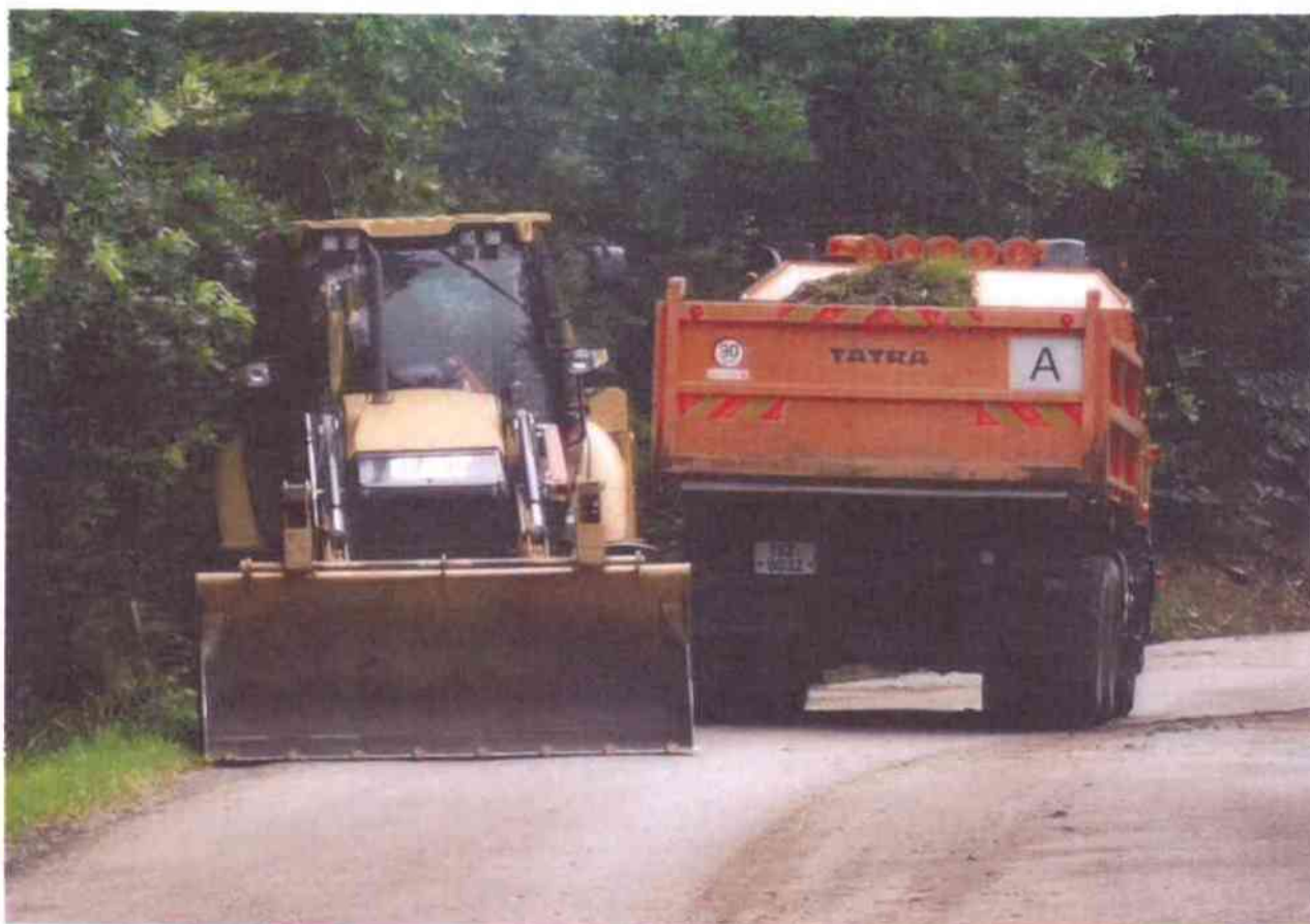
sejmutí drnů s odvozem na 1. úseku
