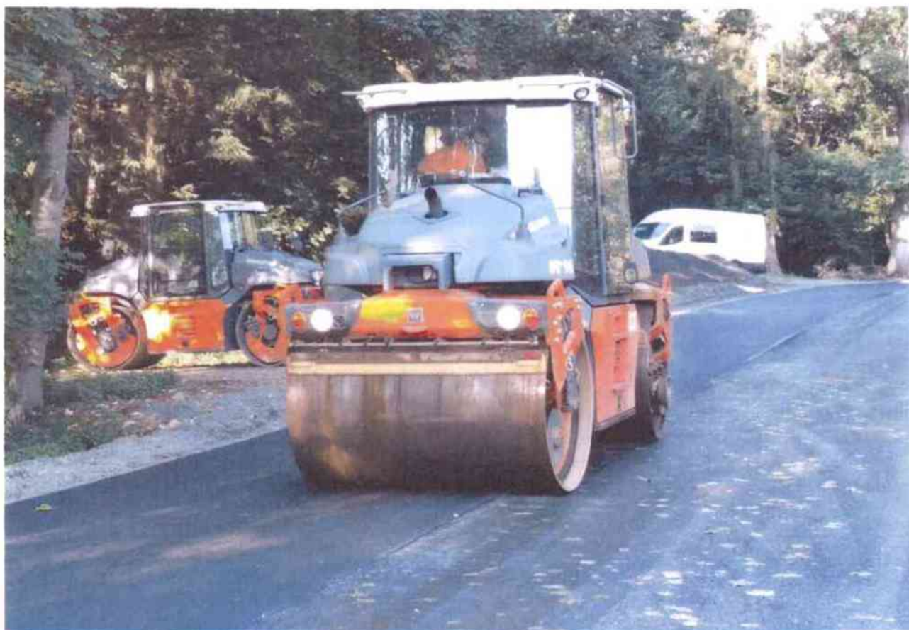
válcování a hutnění po pokládce ACL 16+
