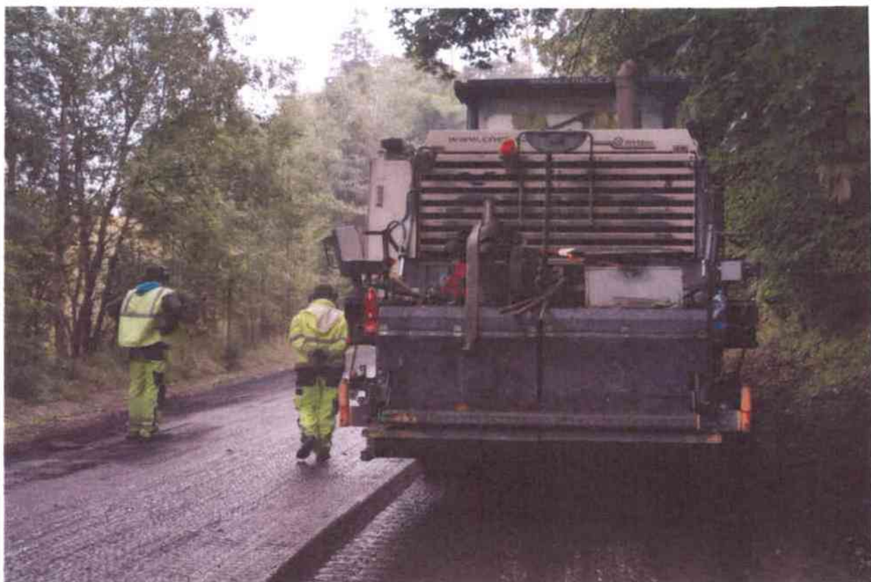
frézování asf. souvrství (2. úsek)
