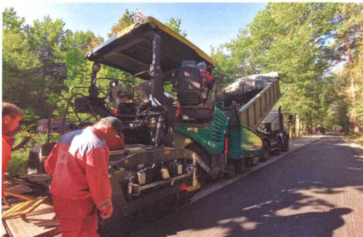
pokládka ACL 16+ finišerem
