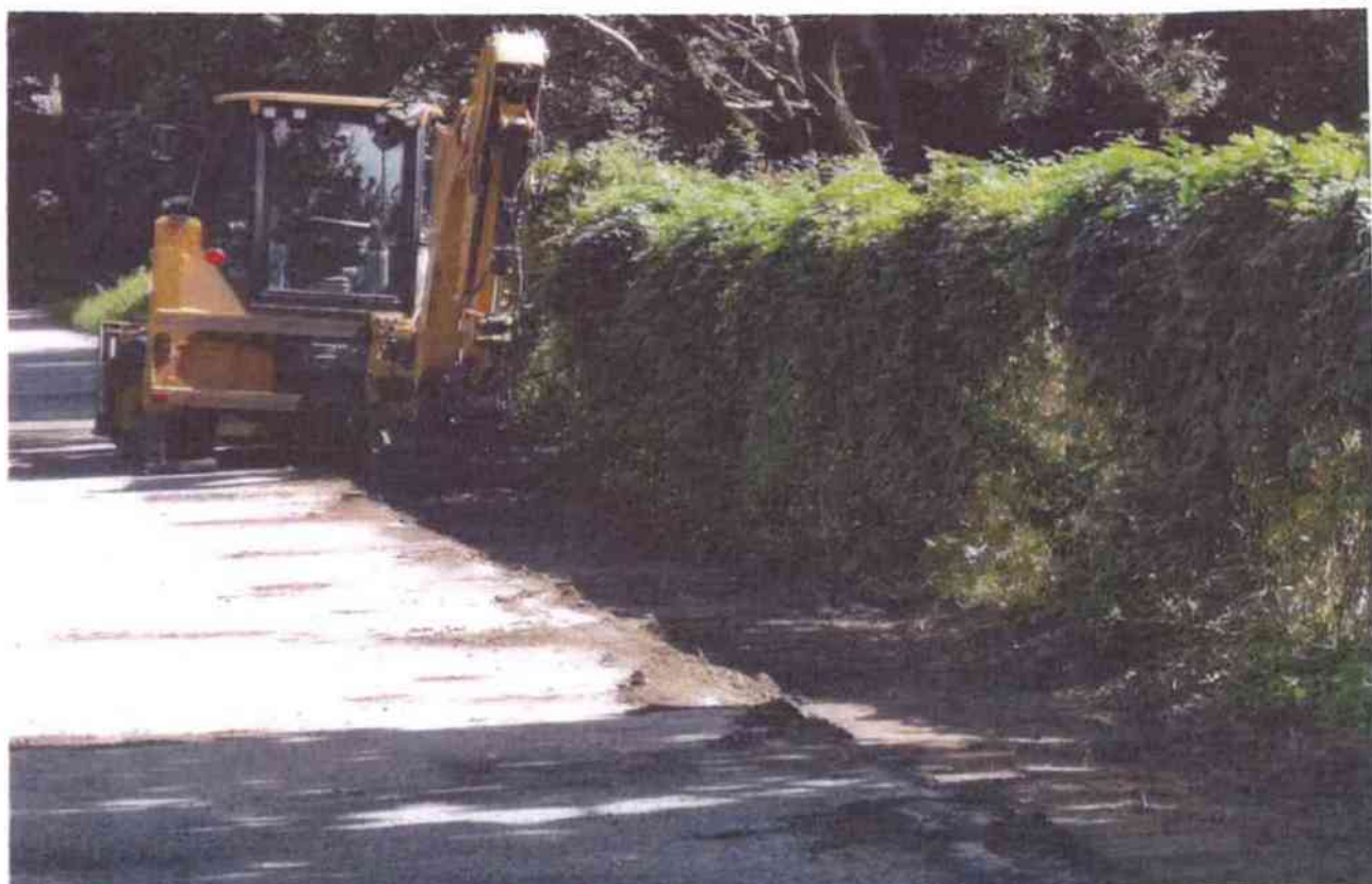
protahování a čištění krajnice (2. úsek)
