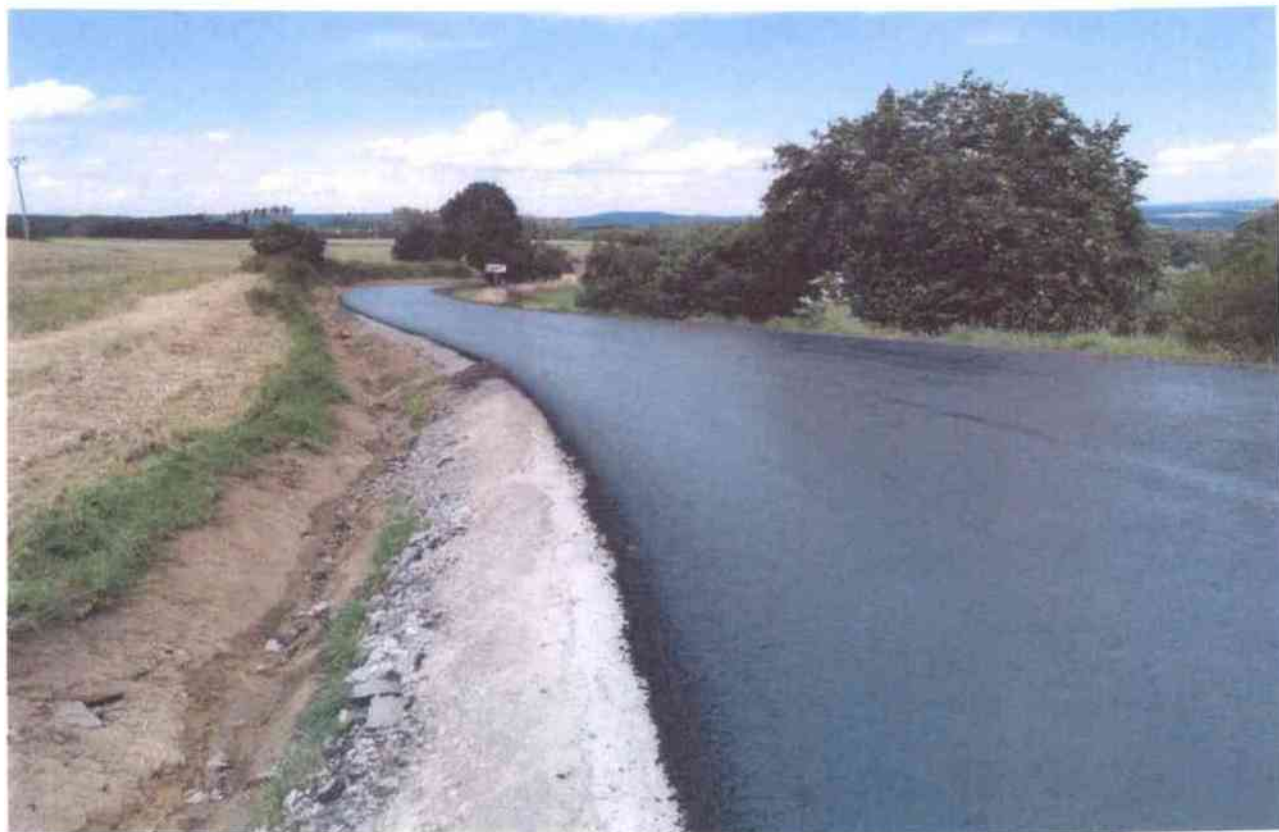
dokončený obrus (1. úsek)
