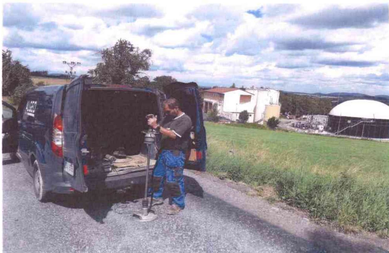
provádění dyn. zkoušek na recyklaci za studena
