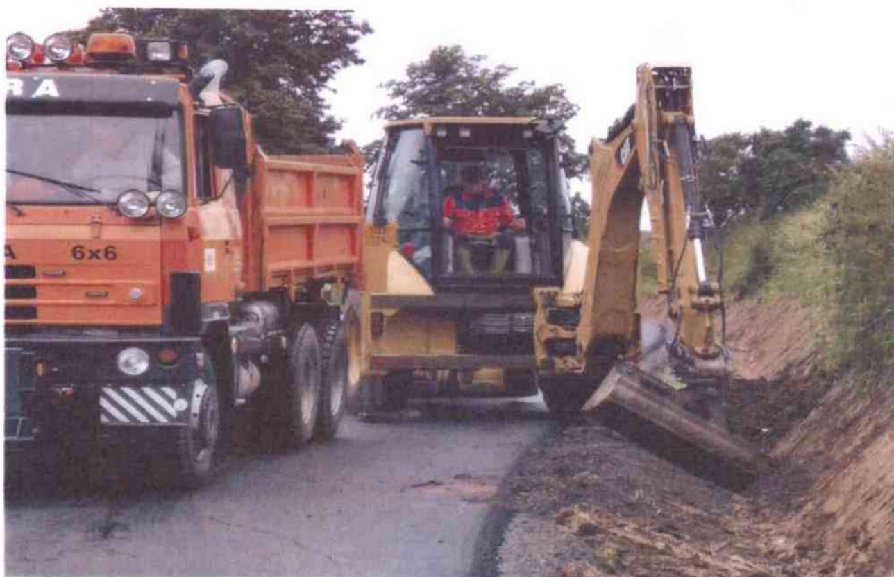
dosyp a urovnání svahu sil. tělesa (1. úsek)
