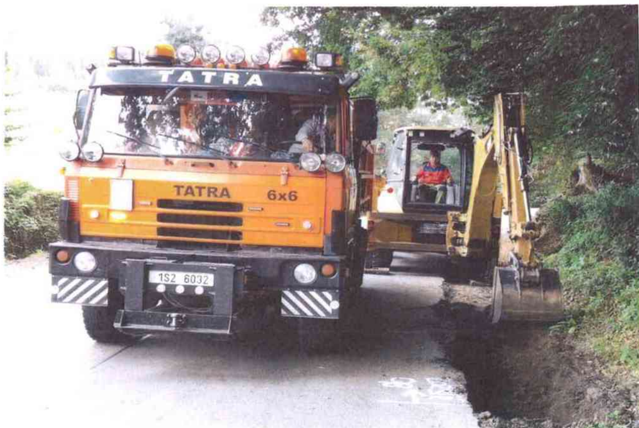
odkop krajnice vlevo (2. úsek)
