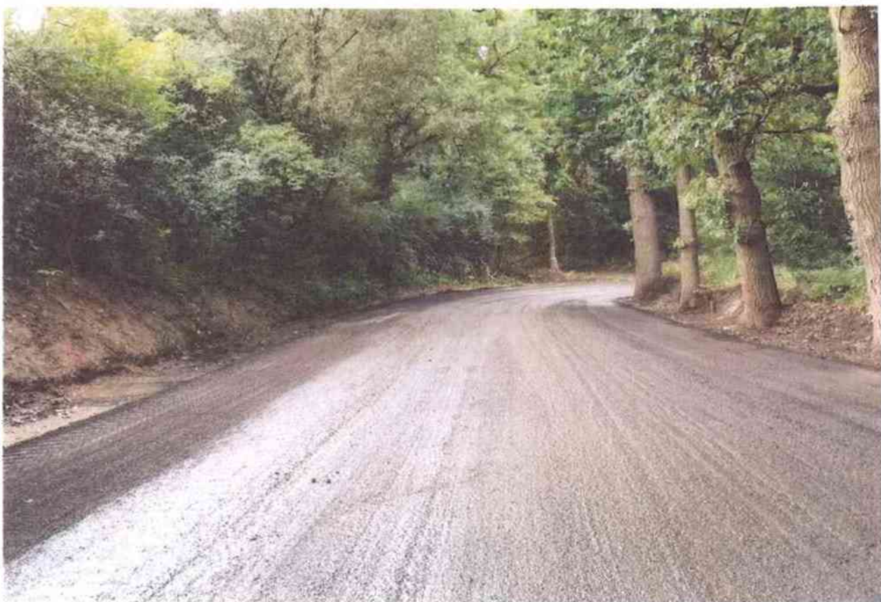
vozovka po odfrézování obrusu
