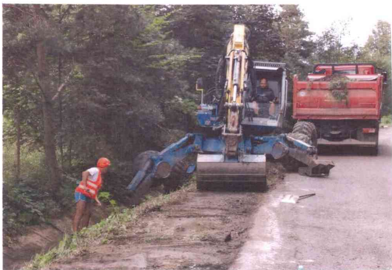
čištění krajnice a příkopu na 1. úseku
