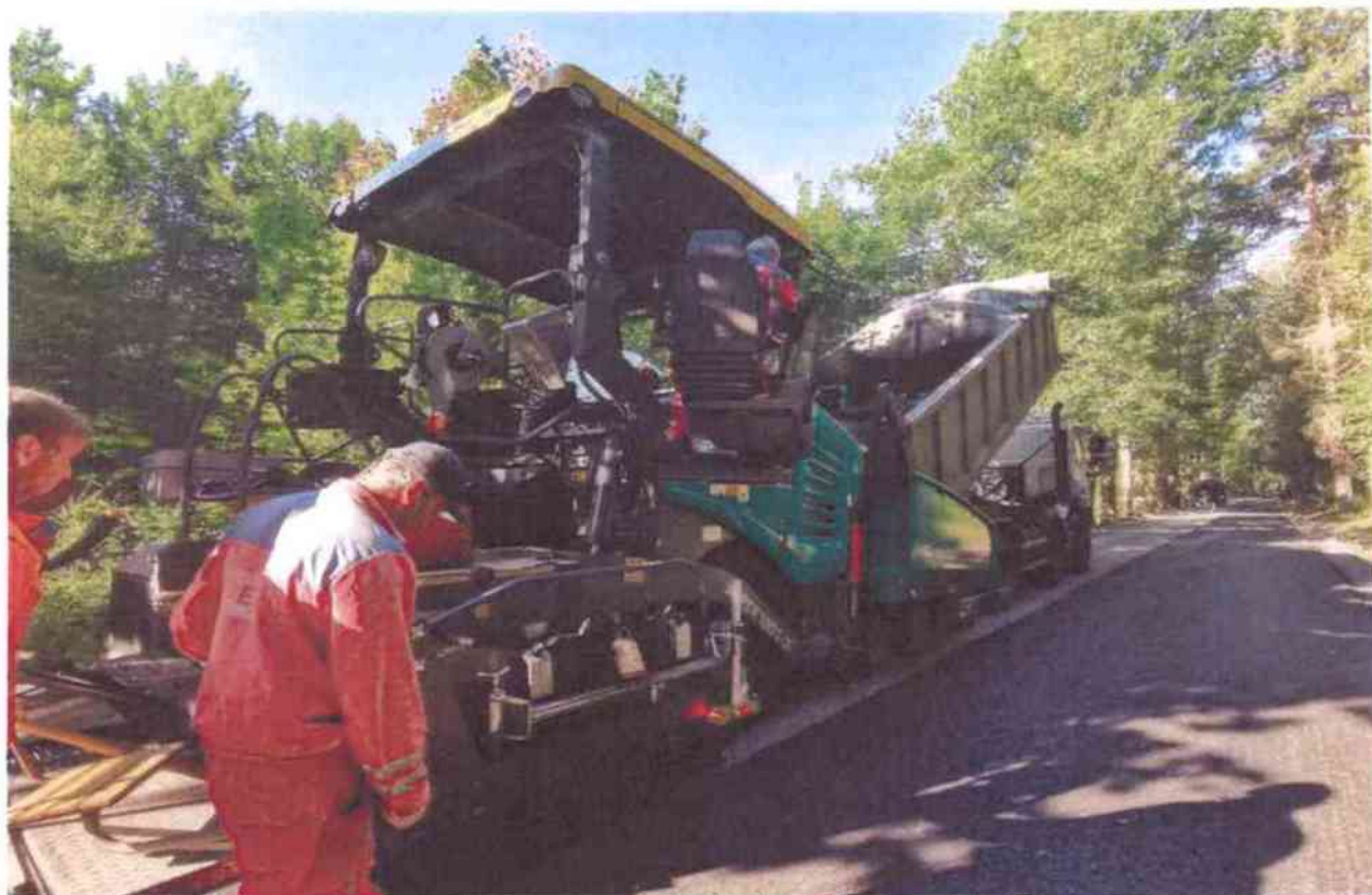
pokládka ACL 16+ finišerem
