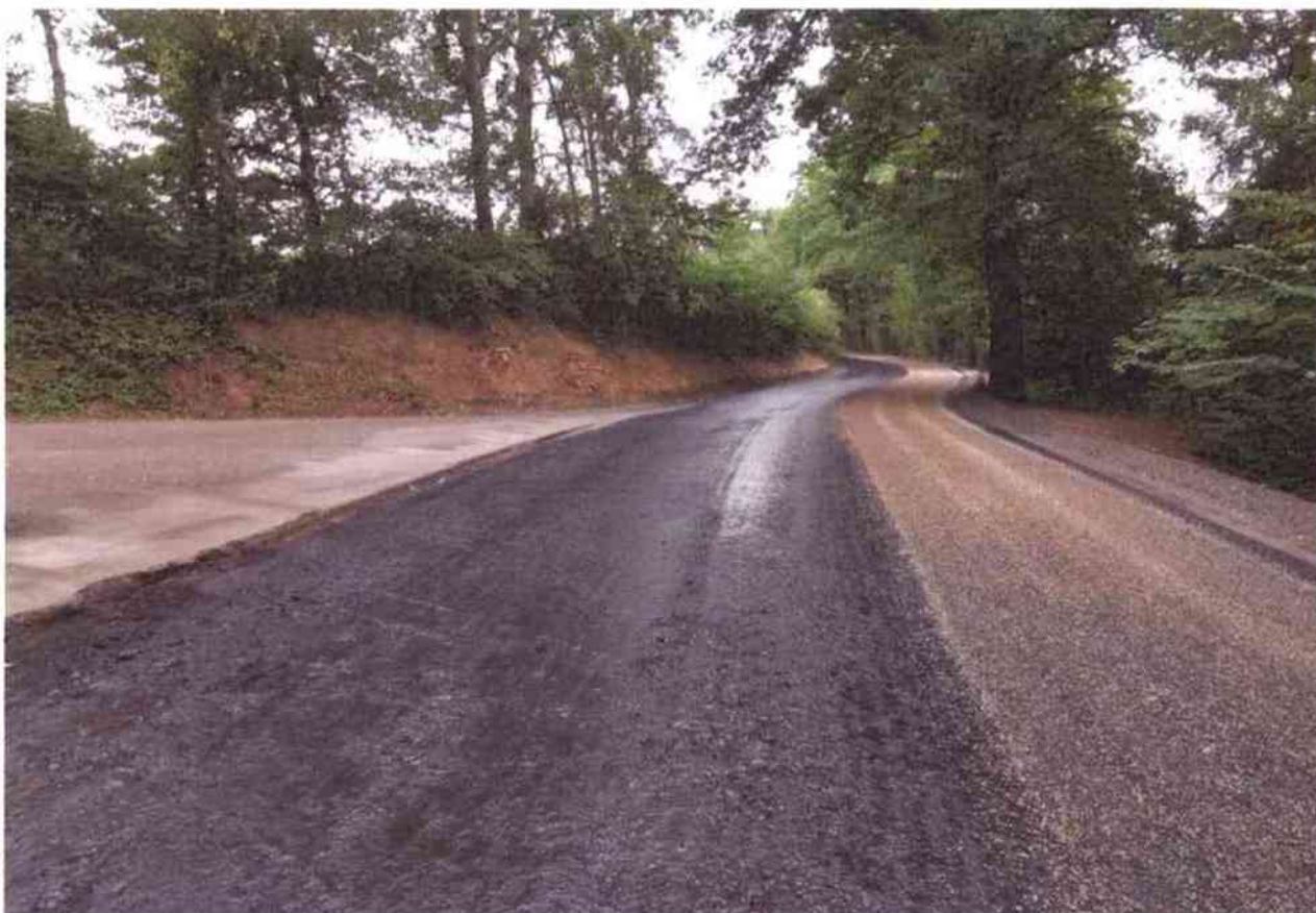
provádění spoj. postřiku
