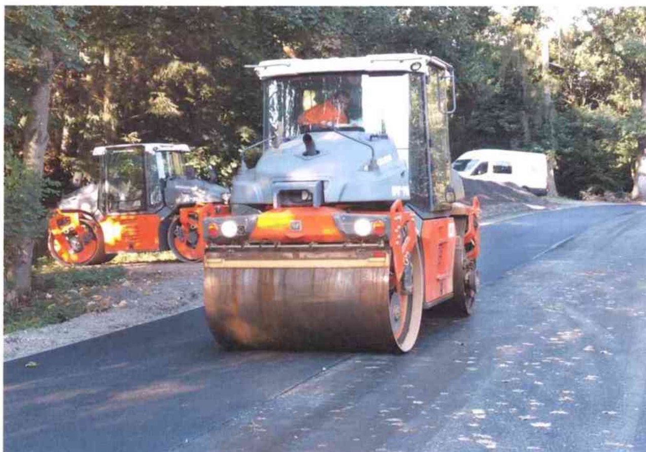
válcování a hutnění po pokládce ACL 16+
