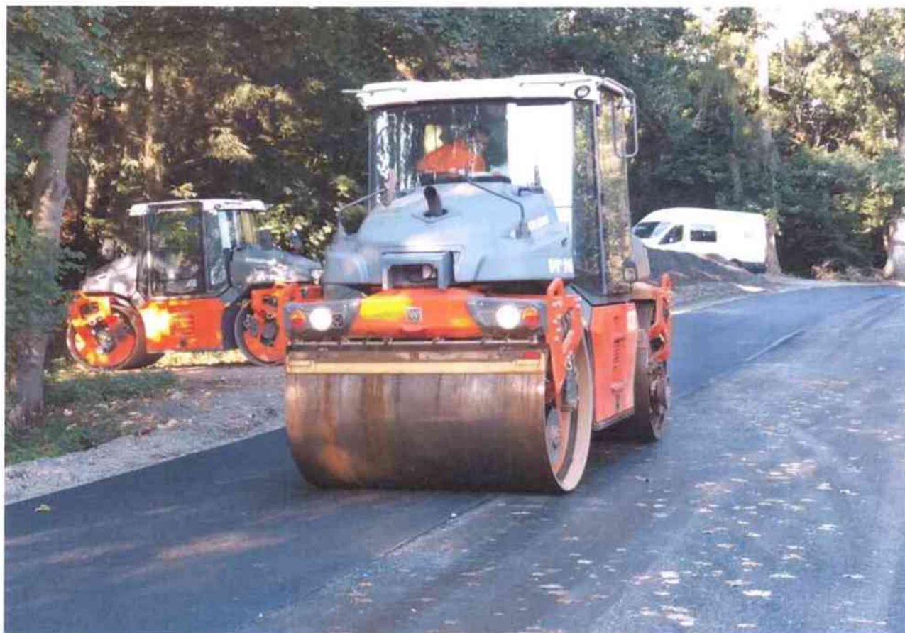
válcování a hutnění po pokládce ACL 16+
