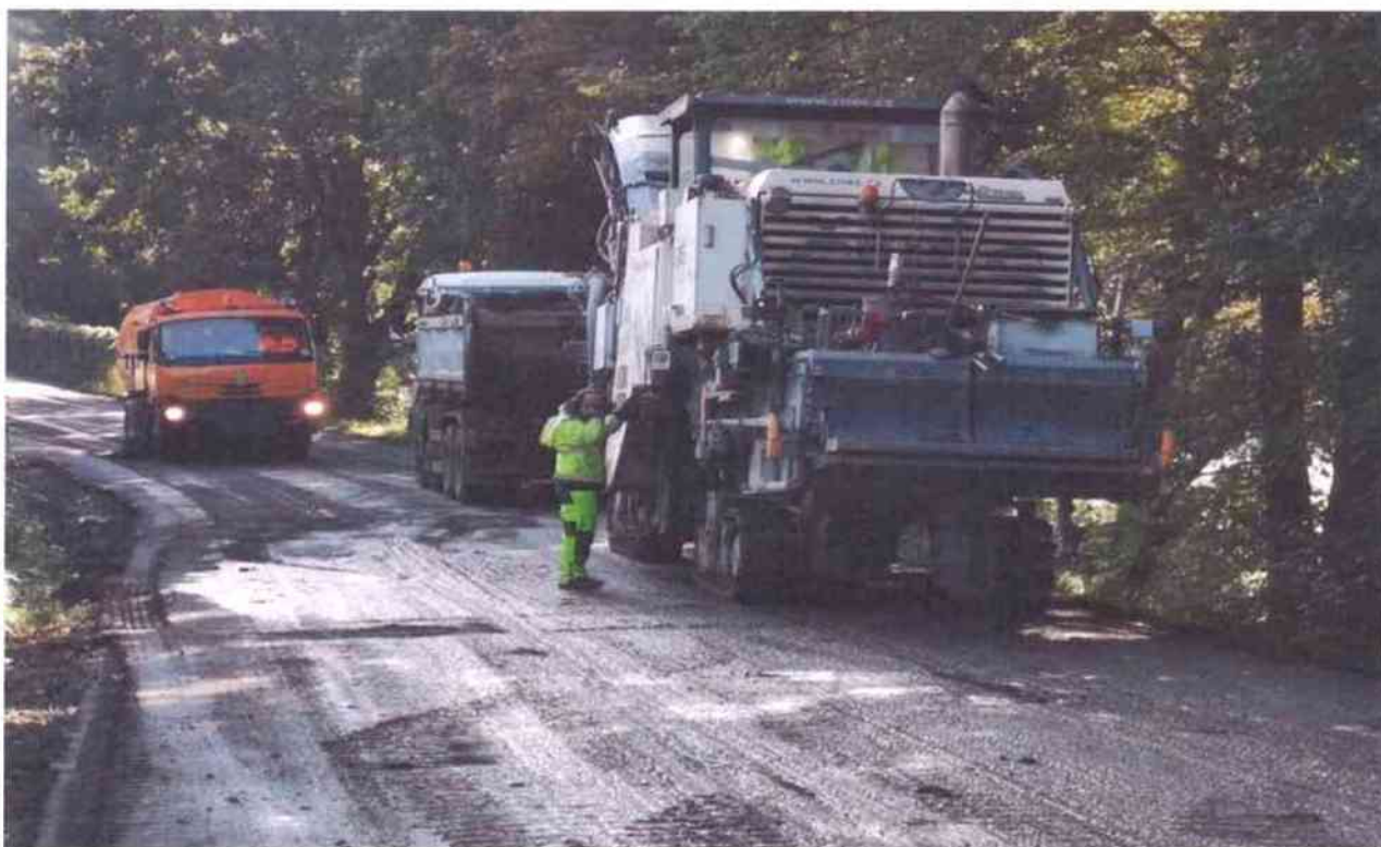
frézování asf. souvrství
