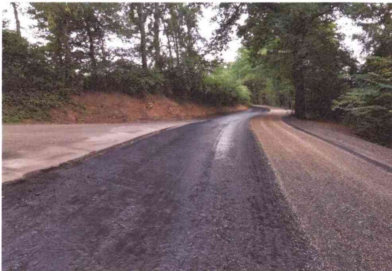
provádění spoj. postřiku
