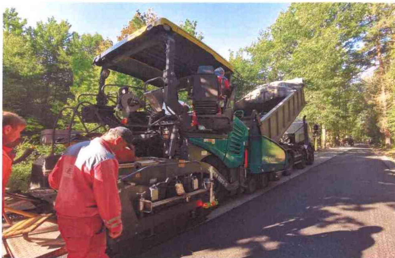
pokládka ACL 16+ finišerem
