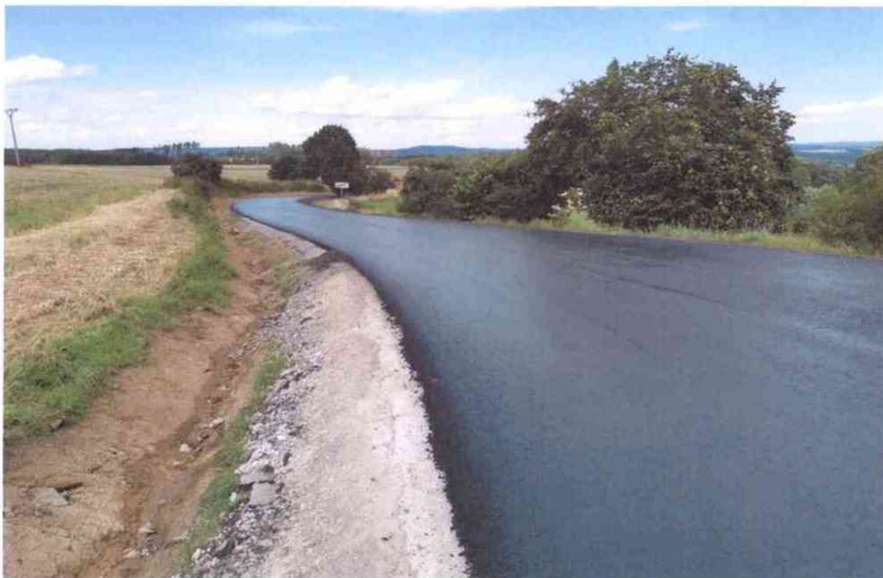
dokončený obrus (1. úsek)
