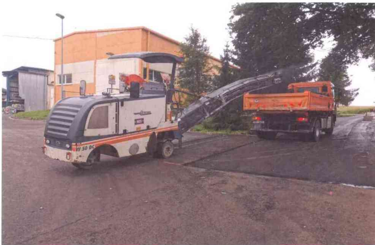
frézování vjezdu na skládku s odvozem na 1. úseku
