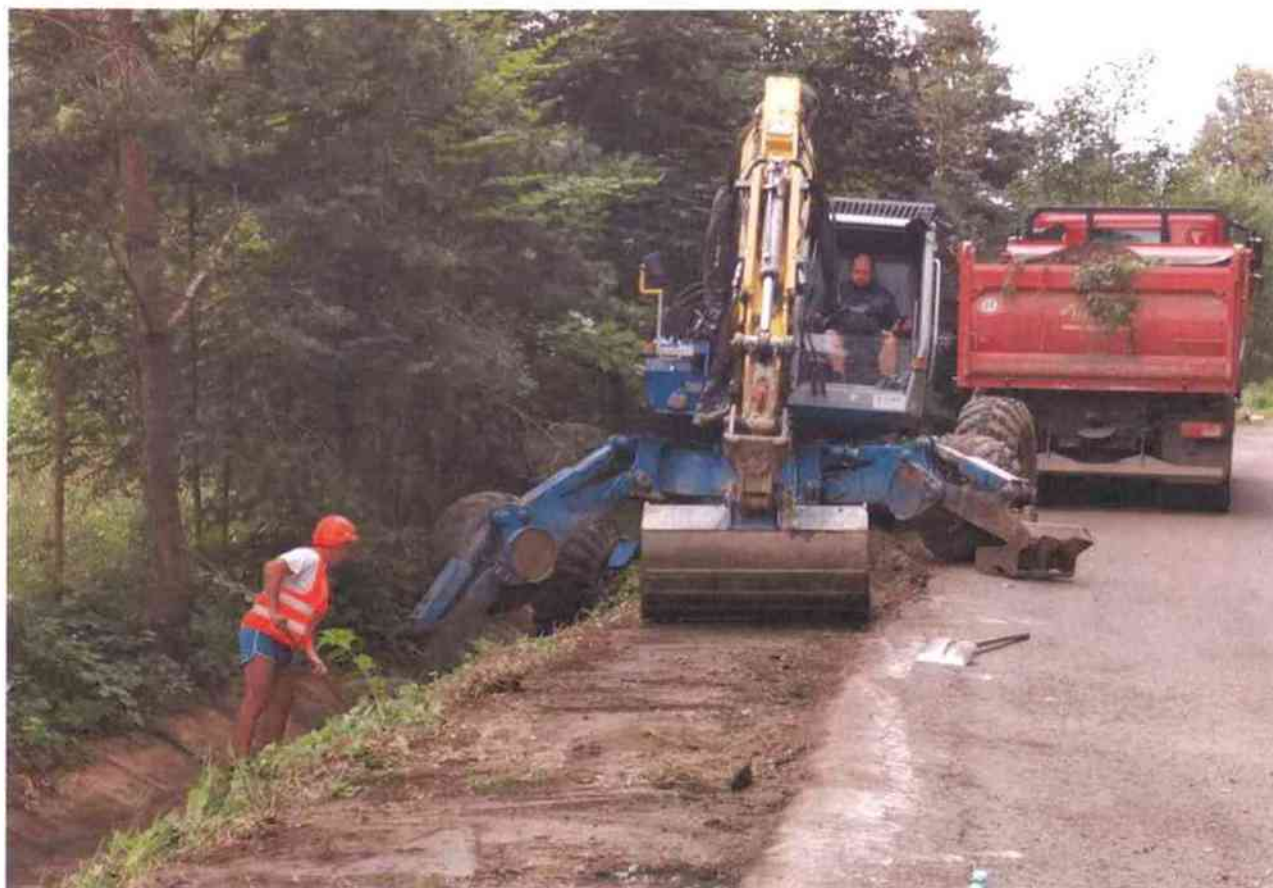
čištění krajnice a příkopu na 1. úseku
