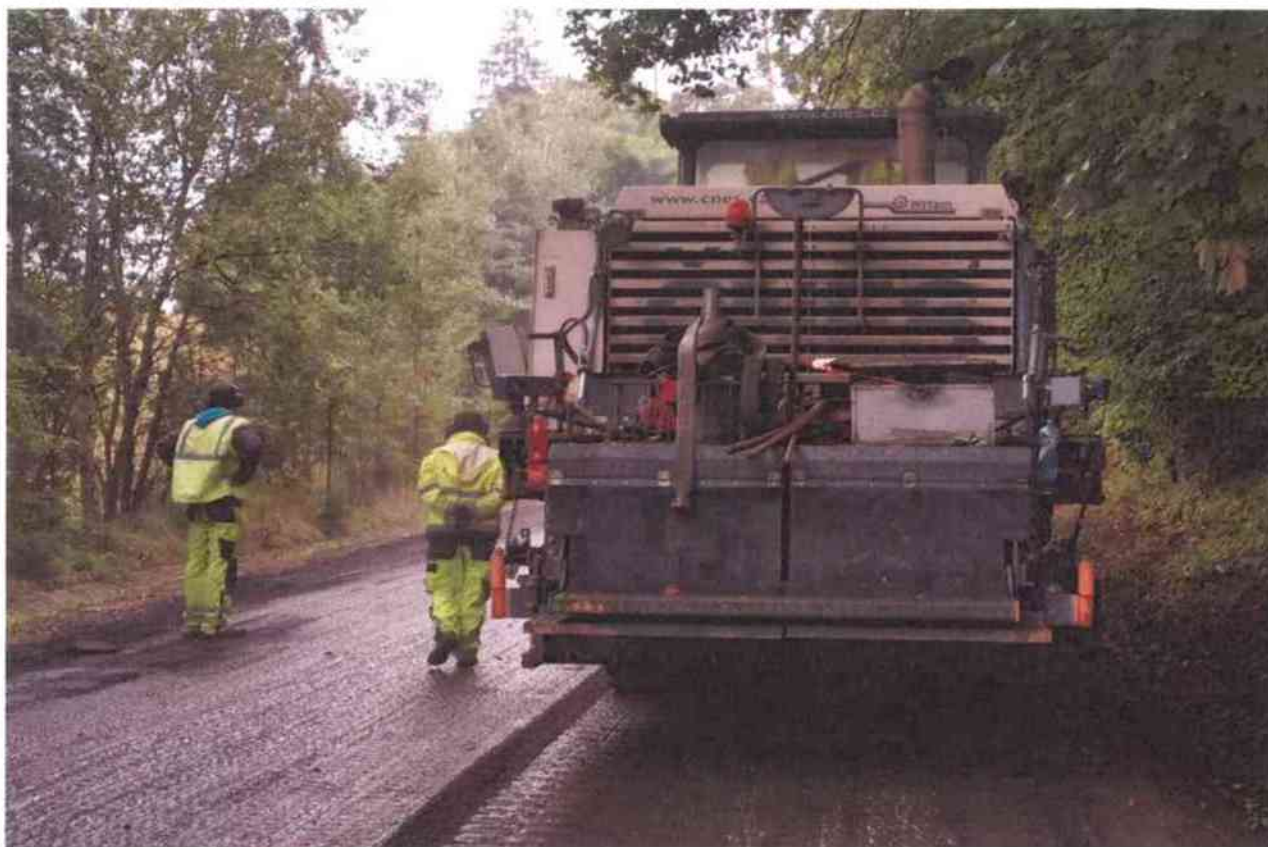
frézování asf. souvrství (2. úsek)
