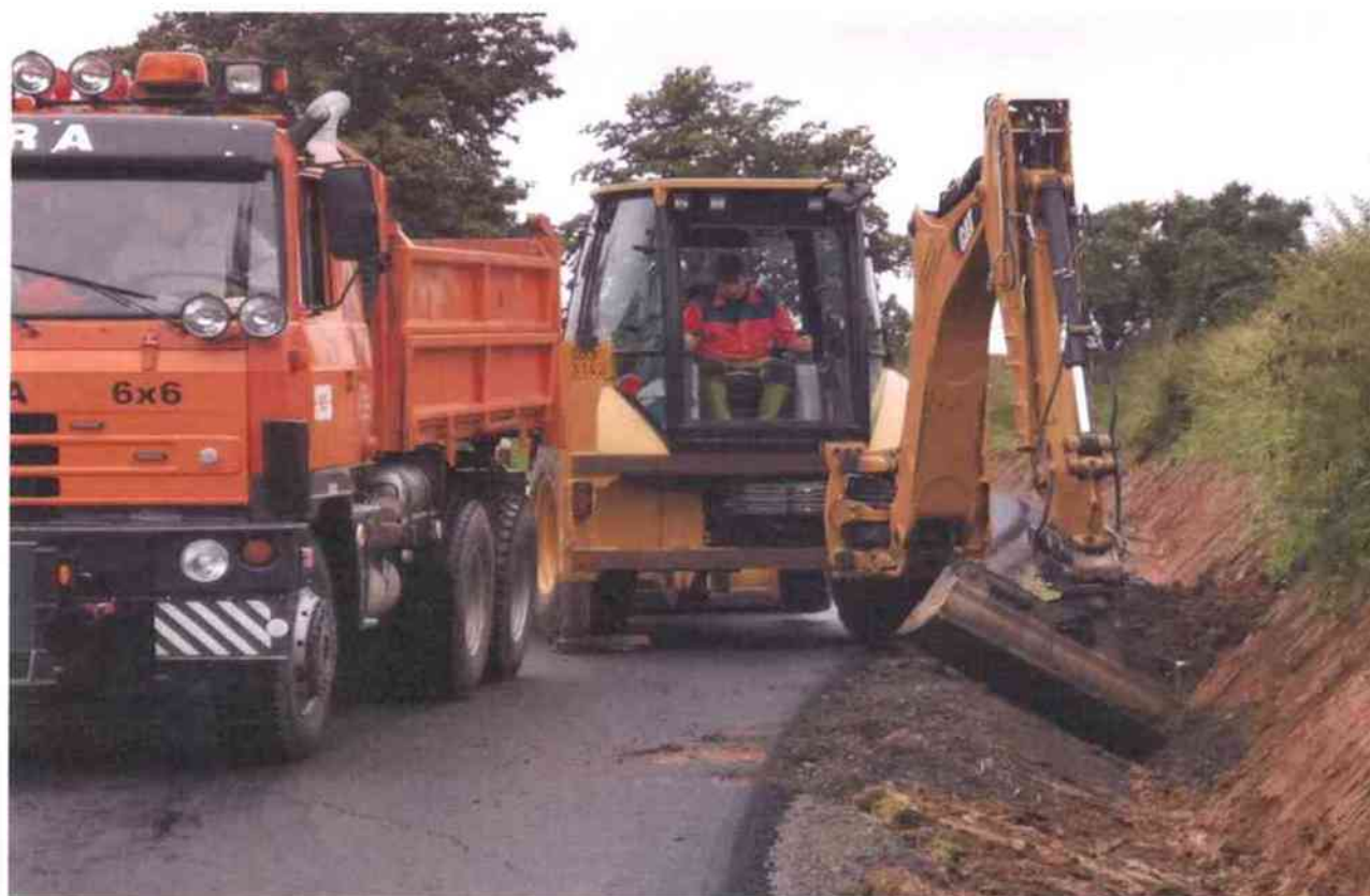
dosyp a urovnání svahu sil. tělesa (1. úsek)
