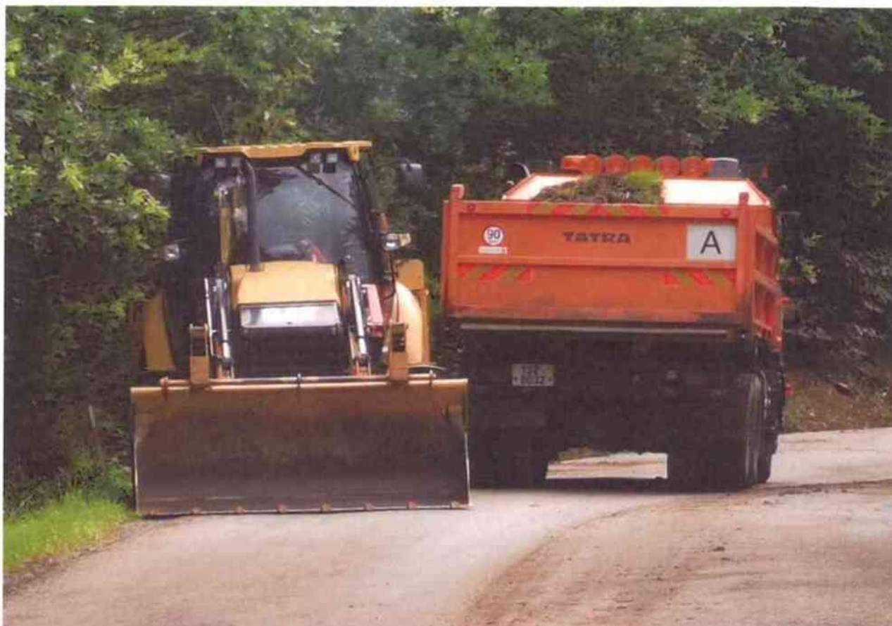
sejmutí drnů s odvozem na 1. úseku
