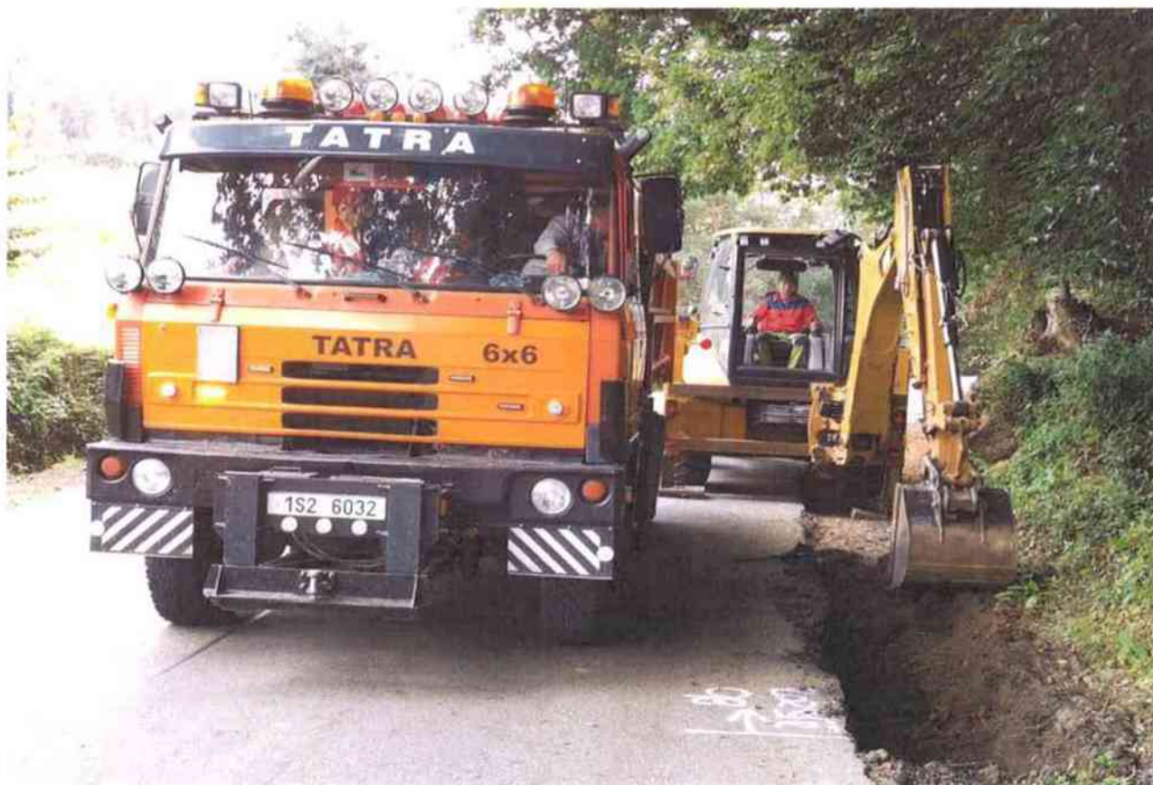
odkop krajnice vlevo (2. úsek)
