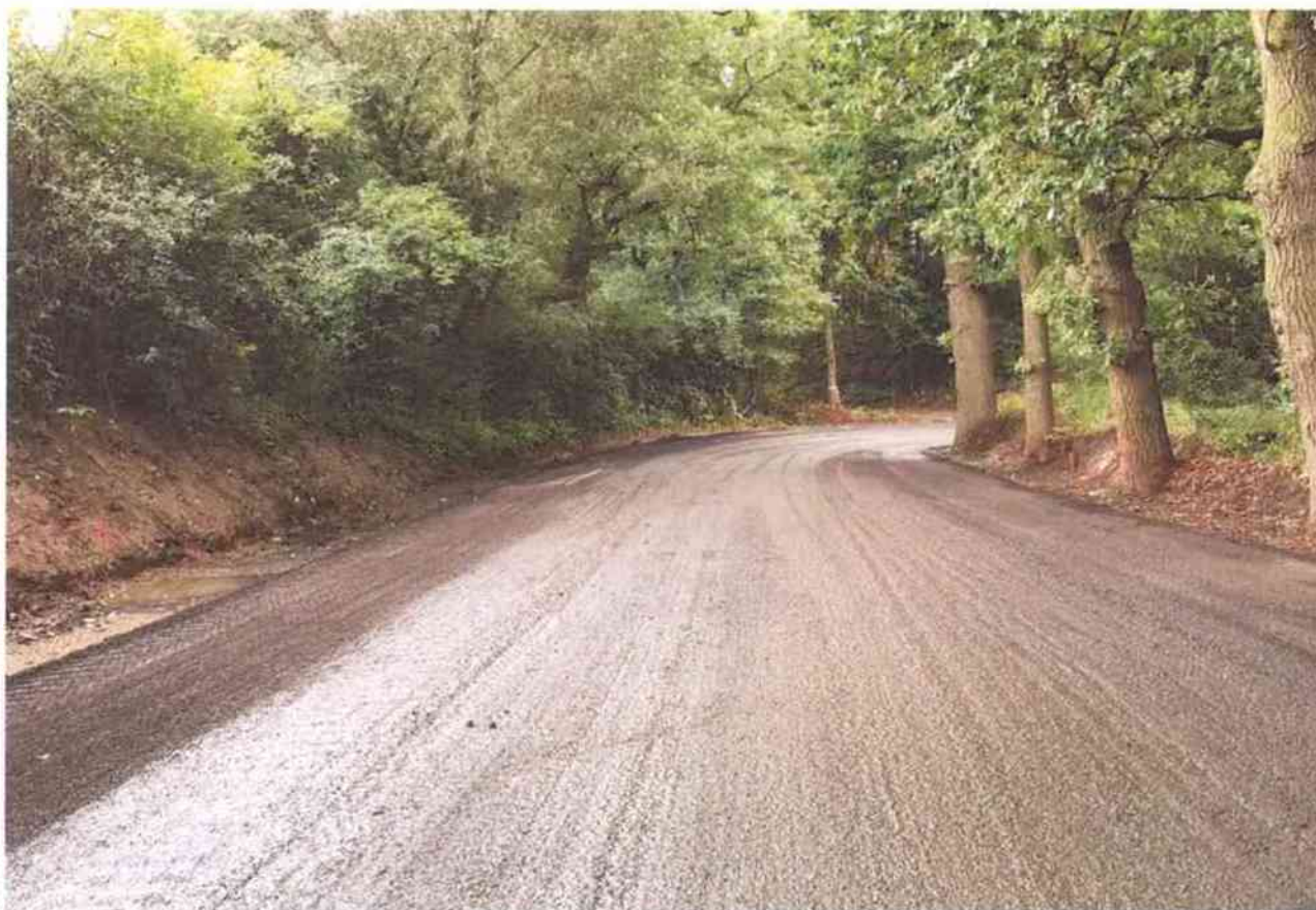
vozovka po odfrézování obrusu
