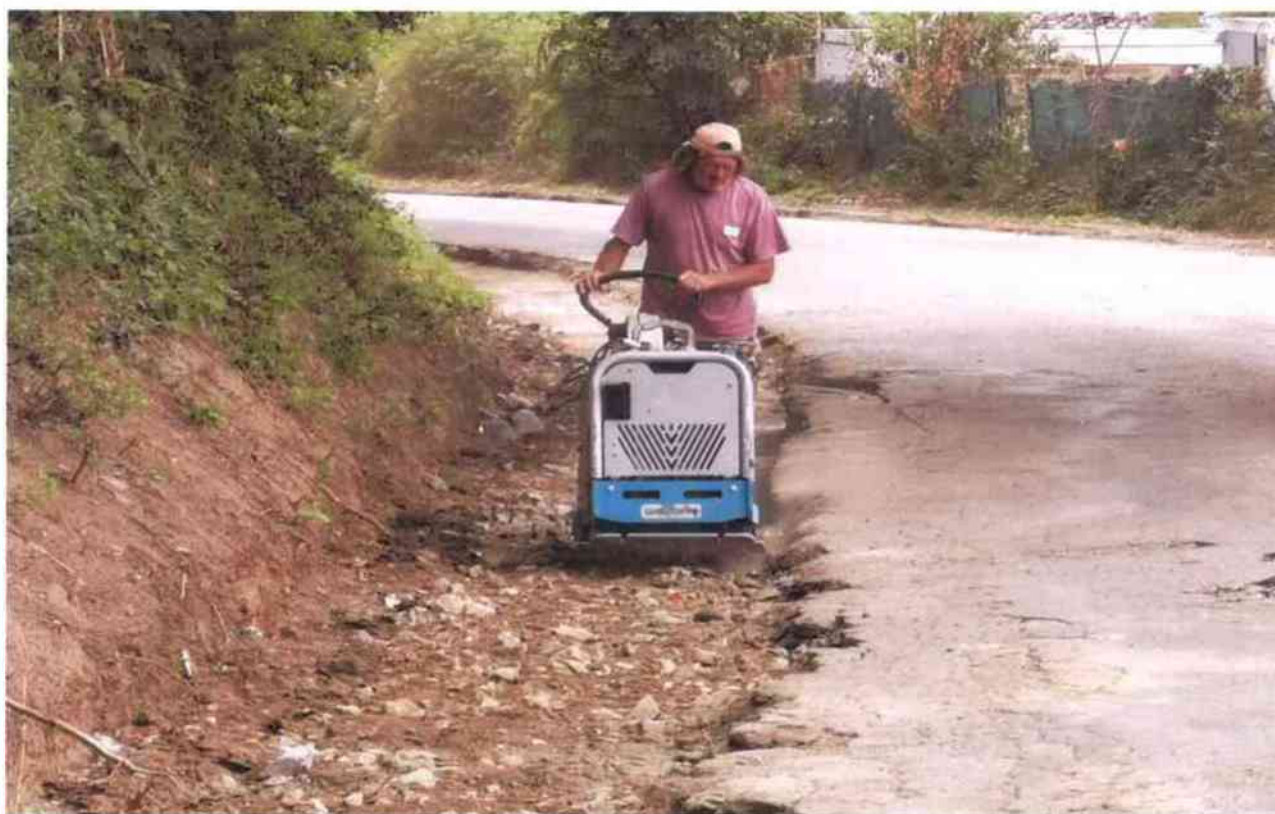
hutnění krajnice levá strana (2. úsek)
