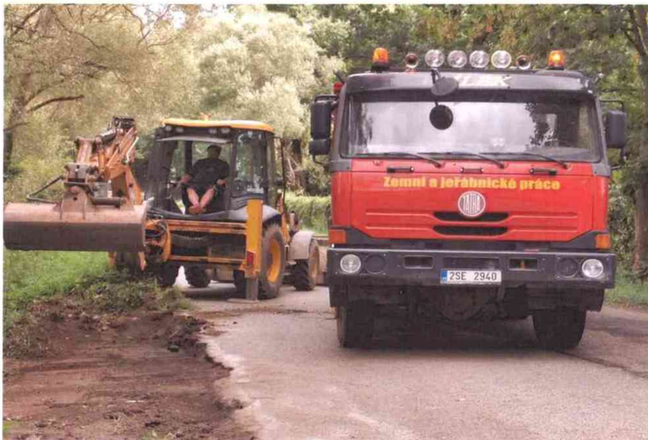
sejmutí drnu z krajnice s odvozem vlevo (2. úsek)
