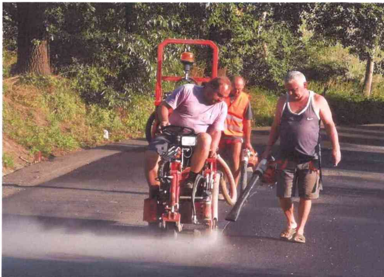
prořez a čištění spáry v obru (1. úsek)
