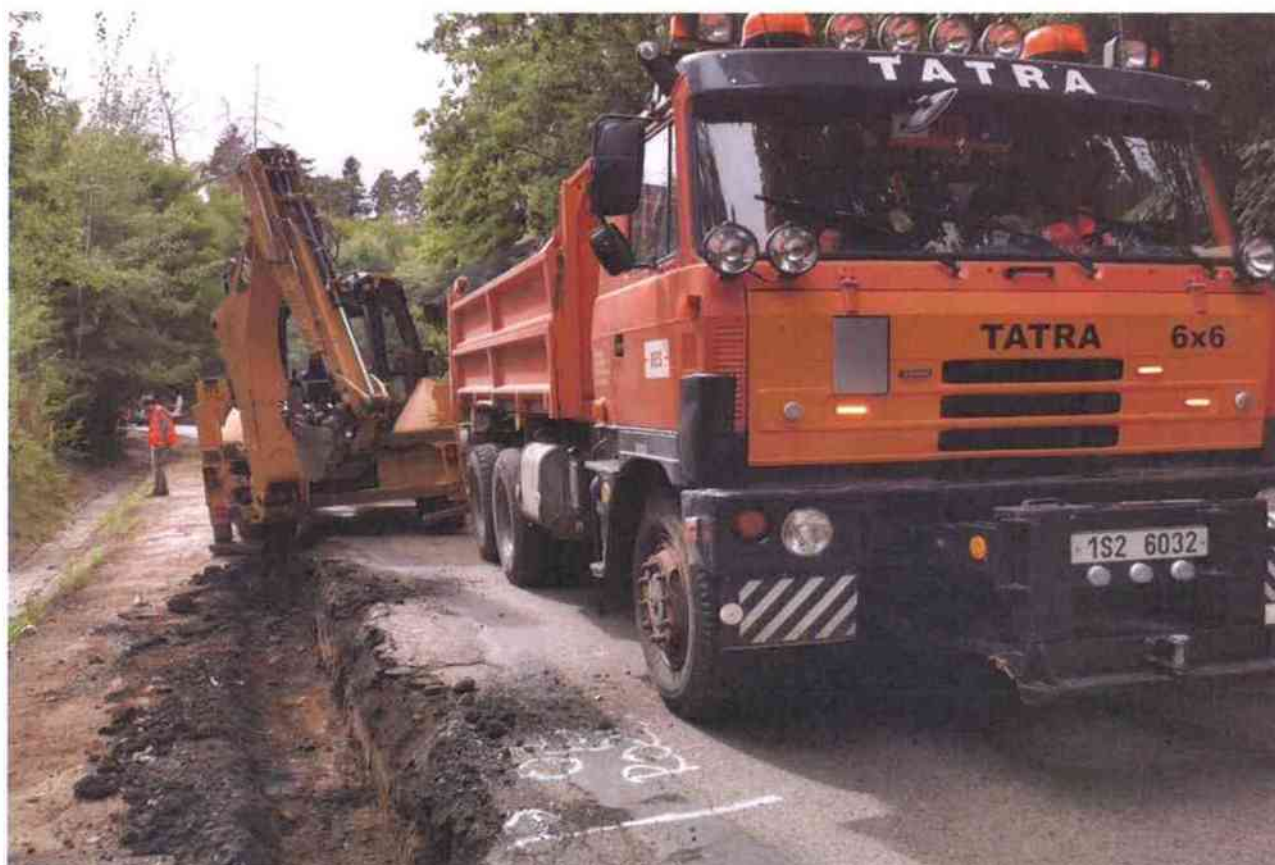
odkop krajnice (2. úsek)
