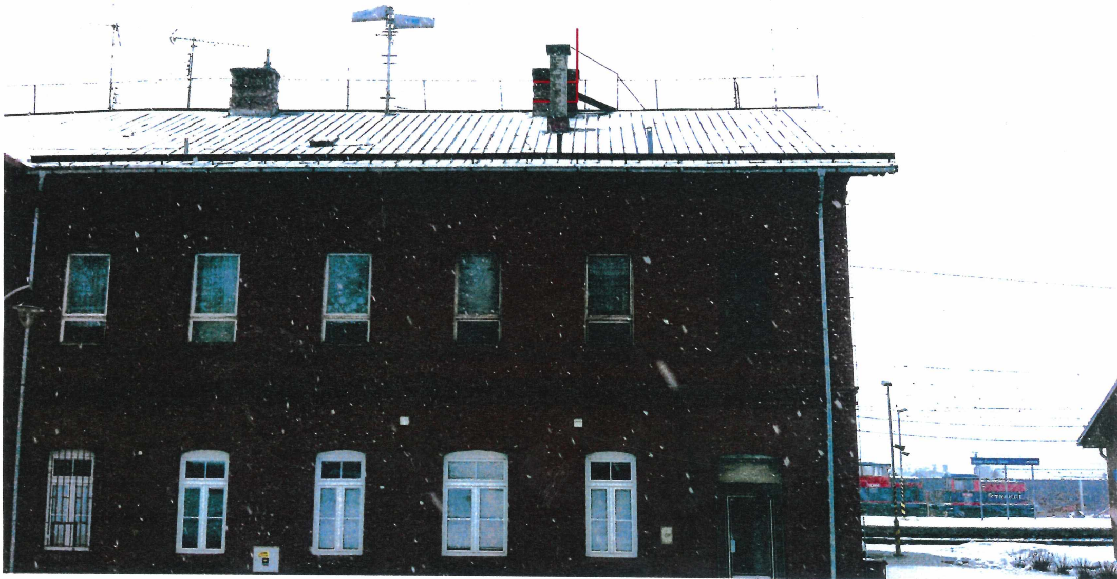
Snímek č.2 - Pohled na budovu se zákřesem stožáru
