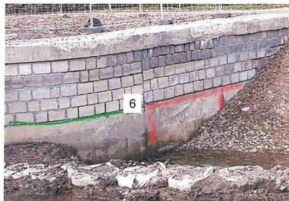
Pravý břehový pilíř a křídlo – nadjezí
