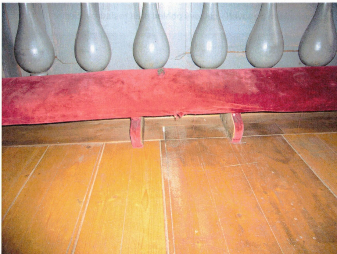
Trhliny, zašpinění a deformace povrchu klekátka - detail před restaurováním
