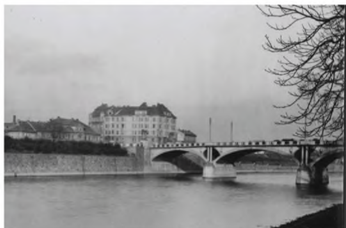
Hlávkův most po dokončení, arch. P Janák
