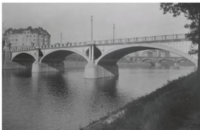
Betonová část Hlávkova mostu, 1912, arch. P Janák Fotografie z archivu IPR, HMP a DPP
