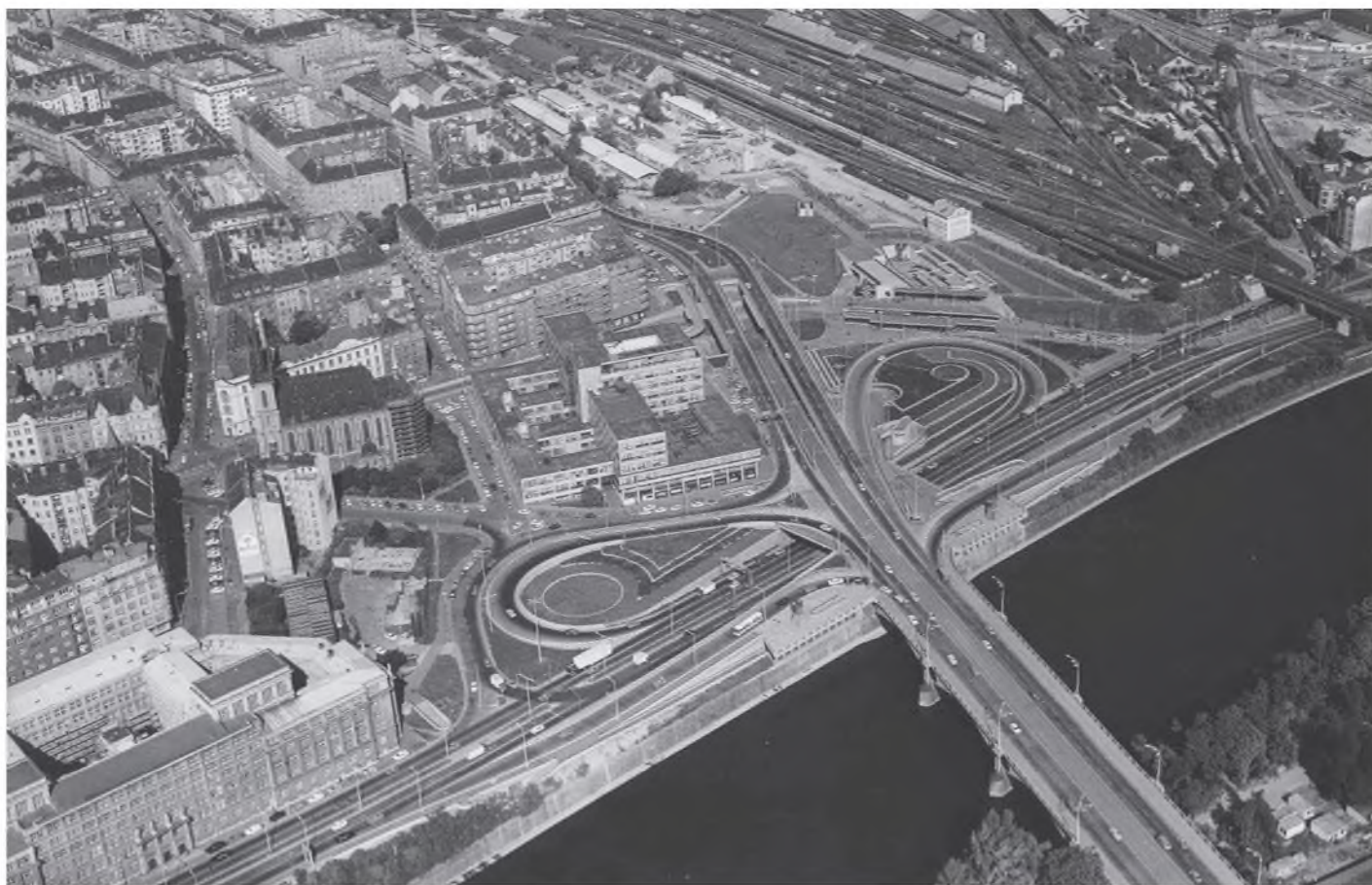
Nadhledová fotografie, dokončení stanice metra Vltavská, 80. léta 20. stol. (archiv DPP)
