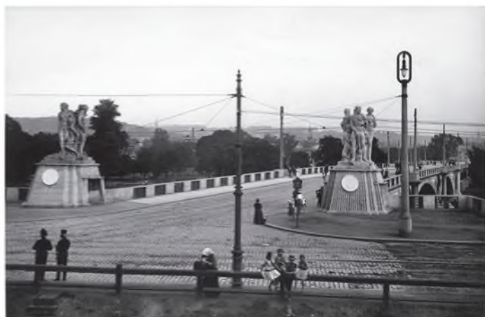
Hlávkův most po dokončení, předpolí mostu, arch. P Janák
