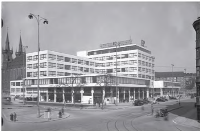
Ústřední budova Elektrických podniků, 1927–35, arch. Benš
