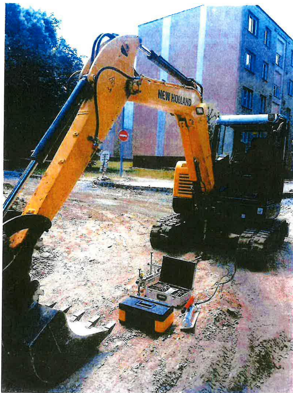
Provedení zkoušek na úrovni pláň
