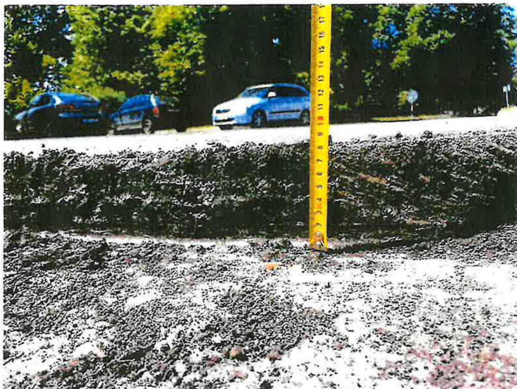
Frézování asfaltového krytu do tl. 100mm
