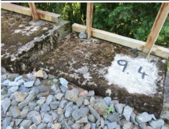
Foto č. 3 Opěra O 01 - přechodová zeď - vpravo
