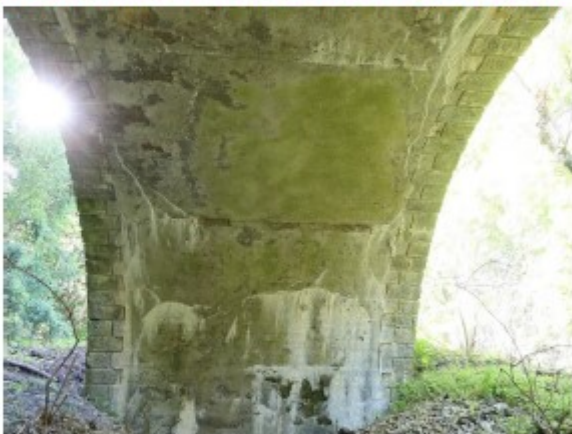
Foto č. 1 Konstrukce K 01
