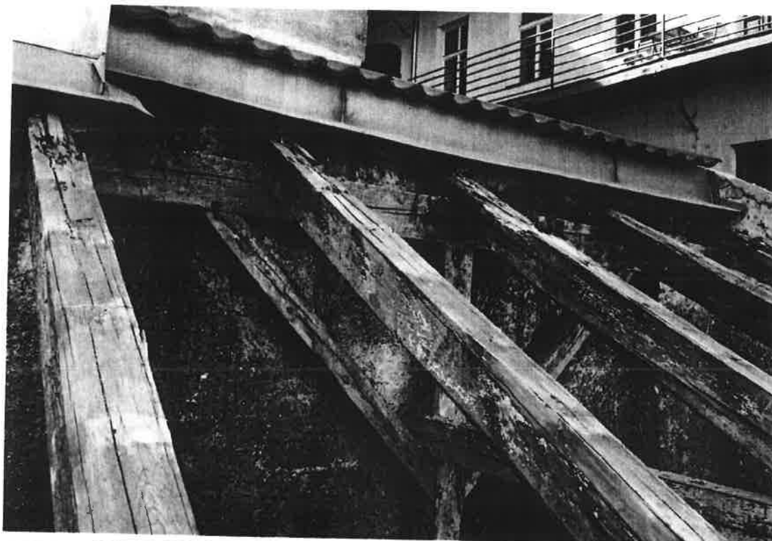
Krov malá přístavba
