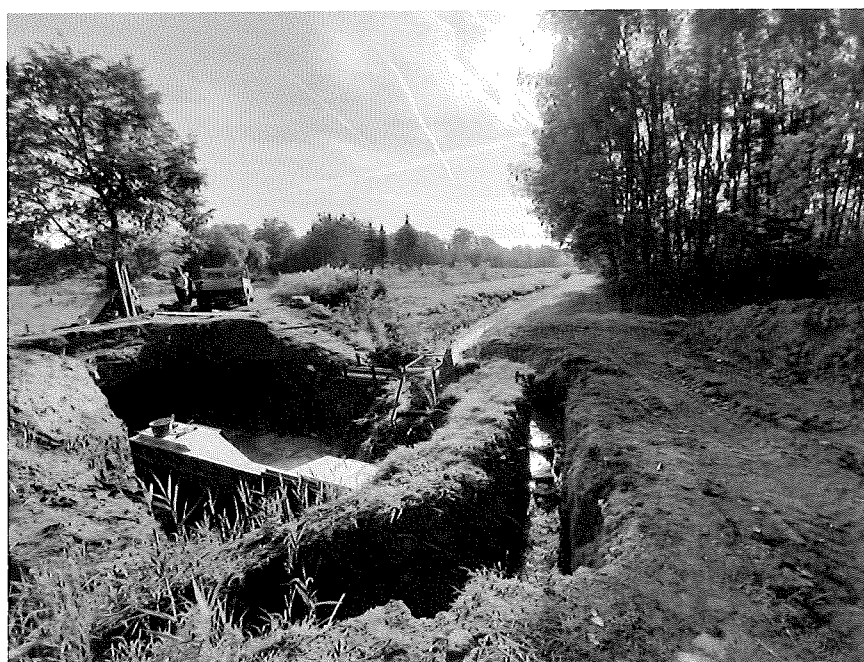
Obrázek 2 Pohled na manipulační objekt
