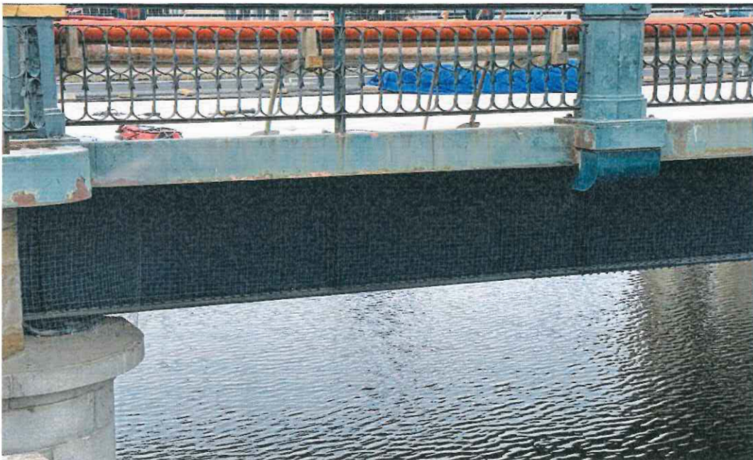
Obr. 3 – síť po provedené montáži
