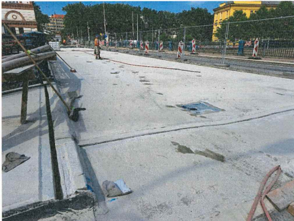
Obr. 3 - provedení podélných a příčných lůžek pro skladbu EMZ
