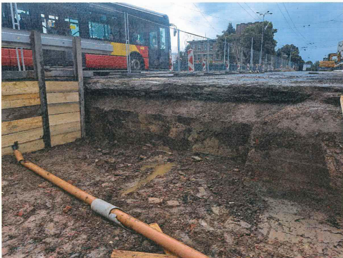
Obr. 1 - stav závěrné zídky OP1 po výkopech
