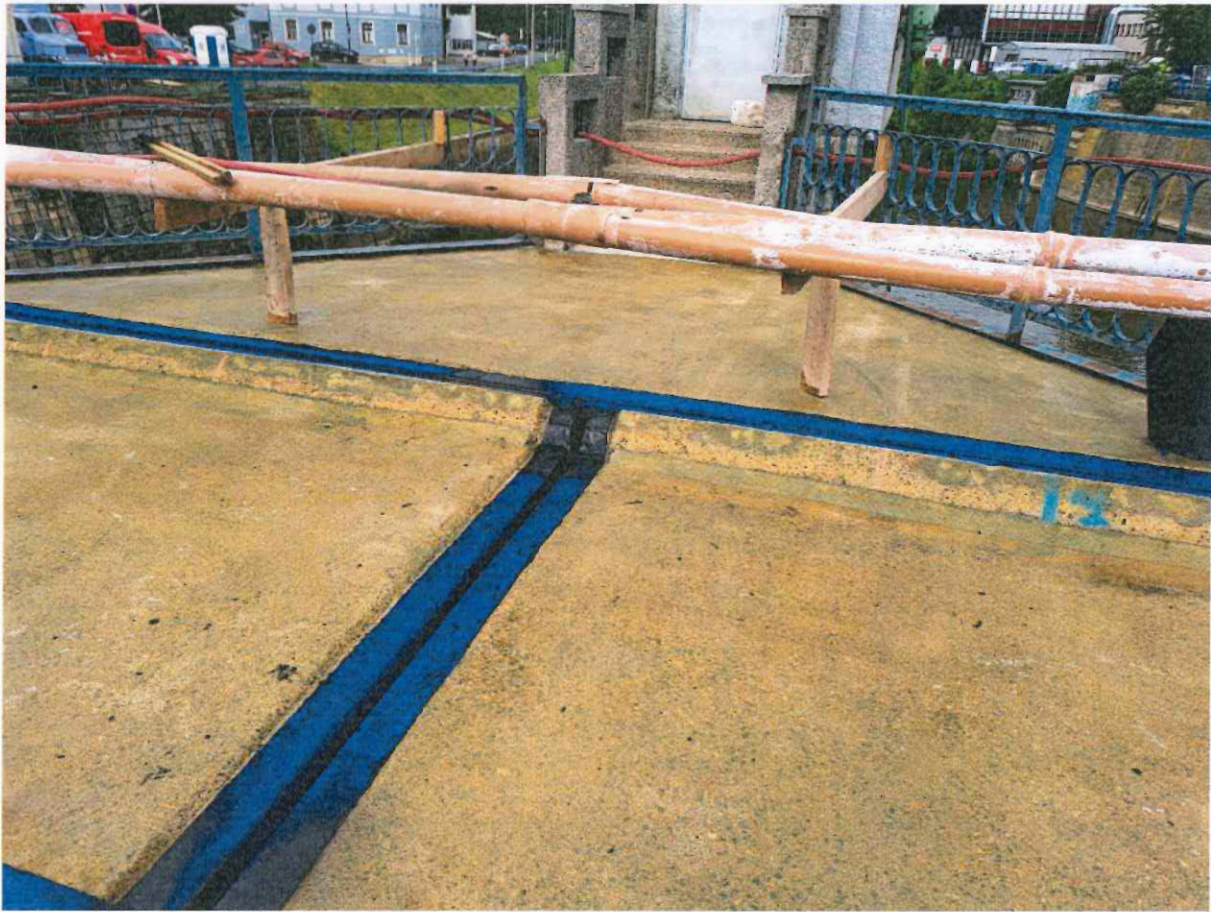
Obr. 4 - natavení NAIP 5 mm tvaru OMEGA do prostoru lůžka
