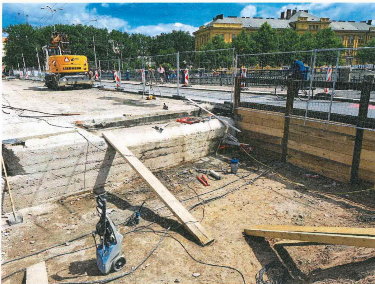
Obr. 2 - stav závěrné zídky OP2 po očištění
