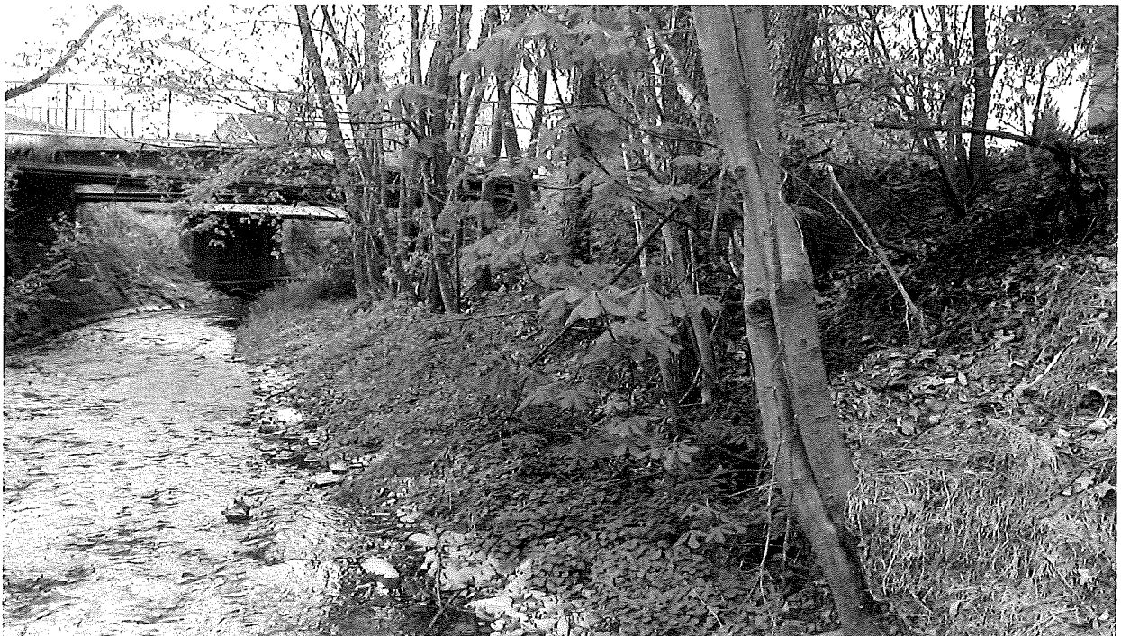
Dřeviny určené ke kácení nad mostem (na pravém břehu), ř. km 0,712 vodního toku
