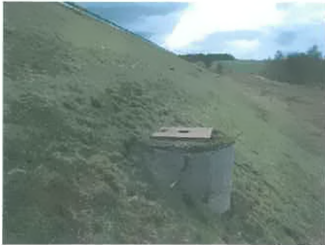
HŠ1 – Vzdušná strana hráze, svah pod lavičkou
