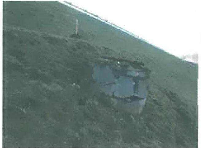
HŠ2 – Vzdušná strana hráze, svah pod lavičkou
