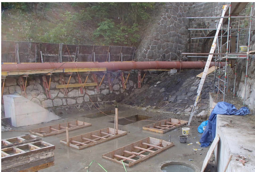
Obr. č.1 – realizace 1 ks rozrážeče ve vývaru I a příprava pro realizaci dalších 6 ks
