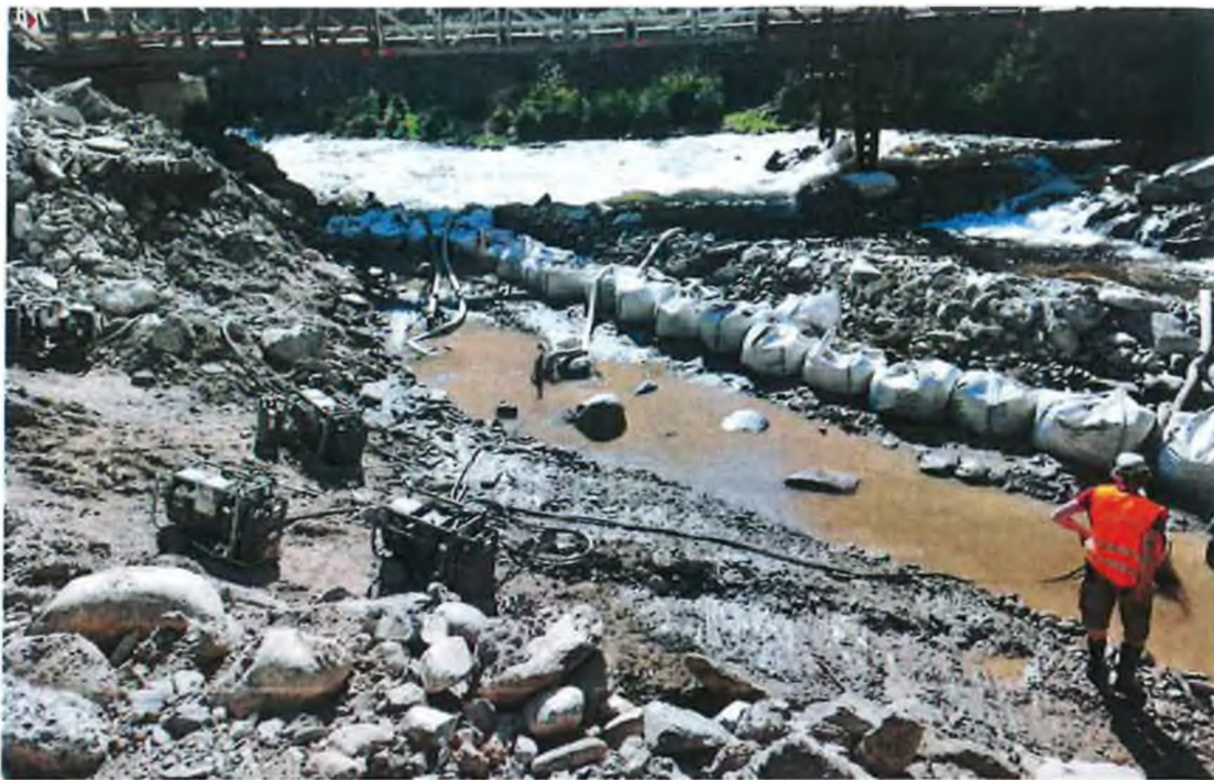
Obr. 2 Snímek z čerpací zkoušky na SO 203 z 11.5.2022.
