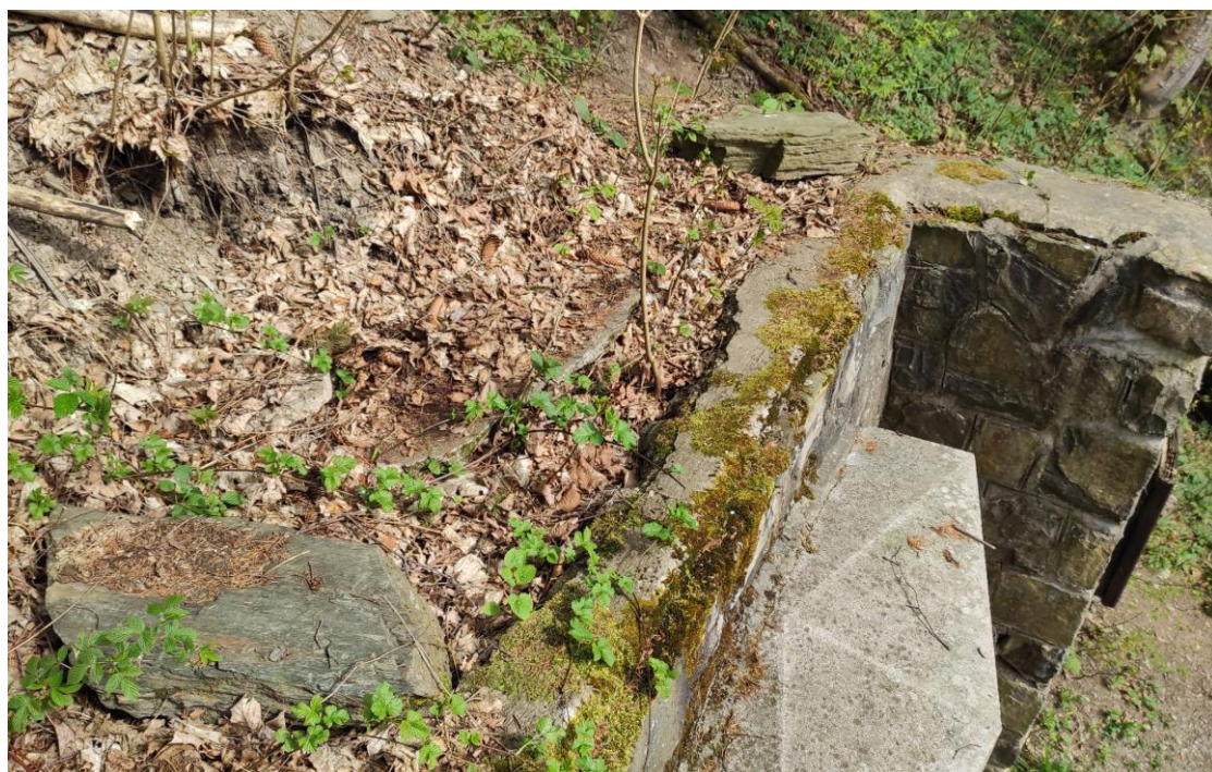
Foto 2,3 Rozvalené části opěrných pilířů, náletové dřeviny a propadlá horní část s rozlámanými kusy betonu
