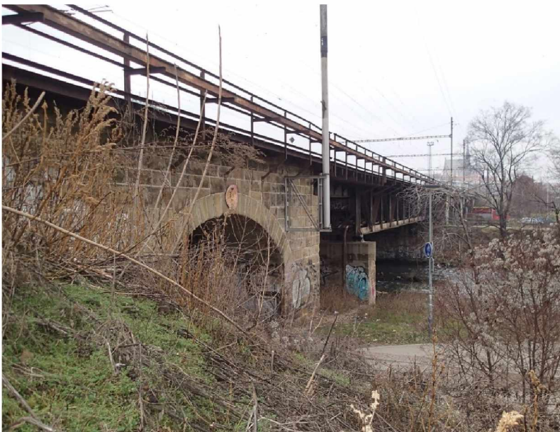
pohled zprava od začátku mostu
