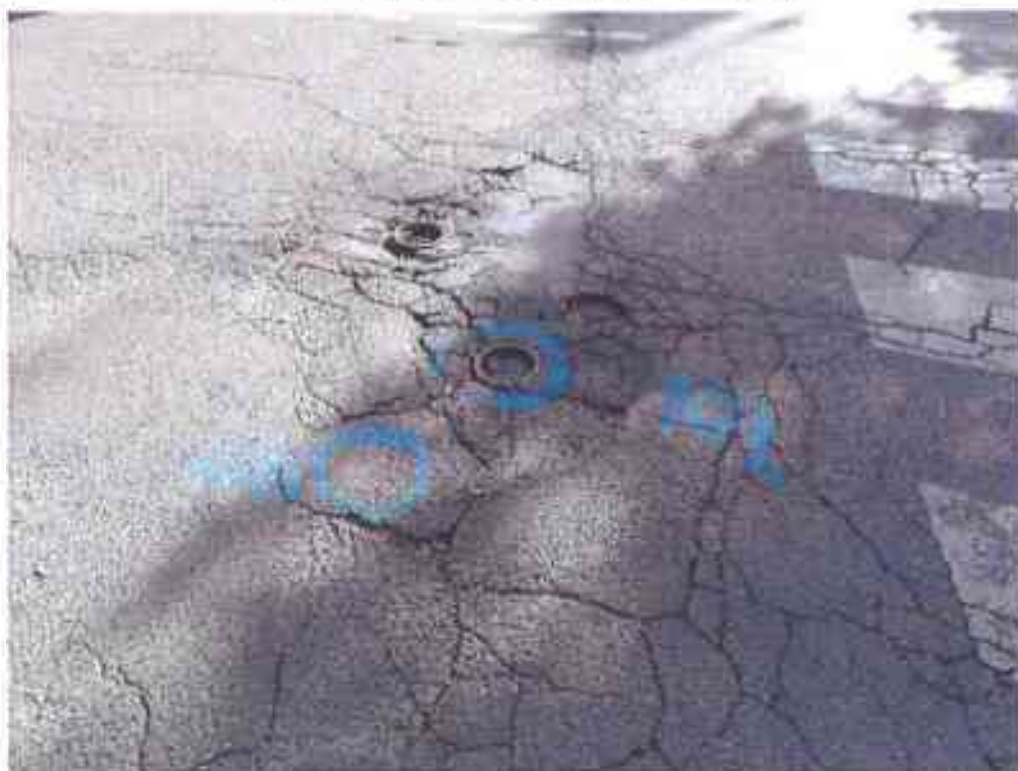
Foto povrchových znaků (vytýčených nebo skrytých)
