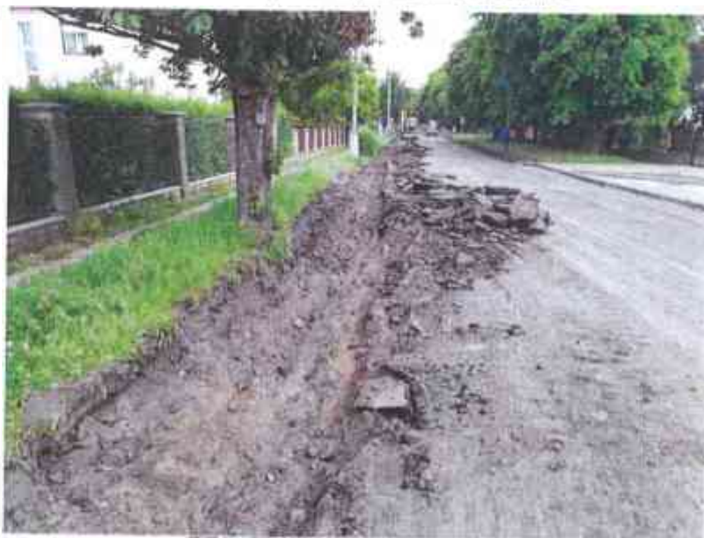
Foto terénních úprav za novými obrubami a úprava vjezdů
