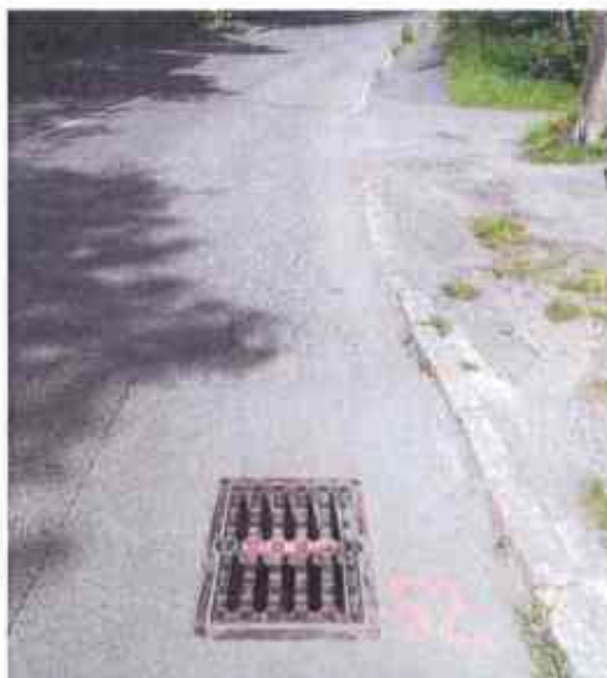
Foto úprav za mostem kvůli odvodnění + úprava přilehlého vjezdu
