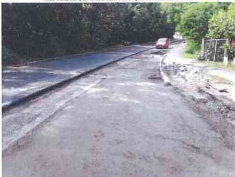
Foto sanovaných míst z kameniva zpevněného cementem
