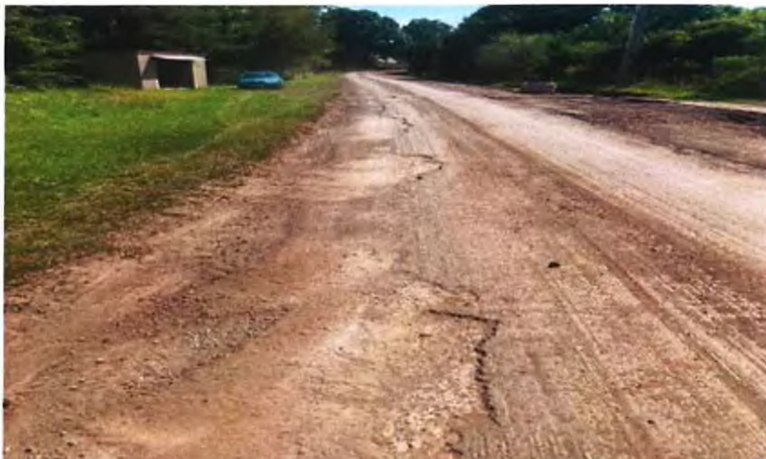
V kraji obnažená vrstva SC po odfrézování 4cm Km- 0,5-0,6
