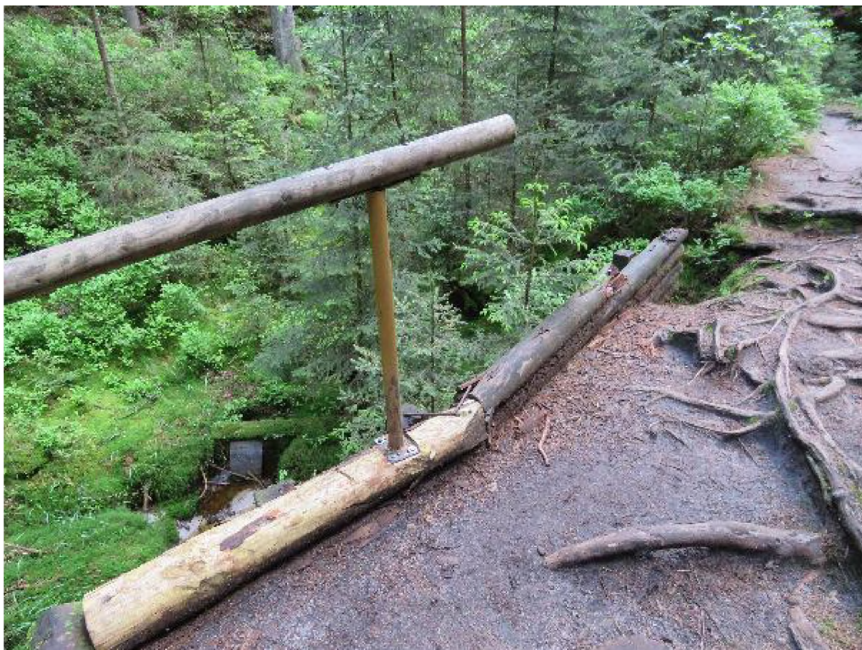
Údržba kovových sloupek zábradlí v počtu 48ks
