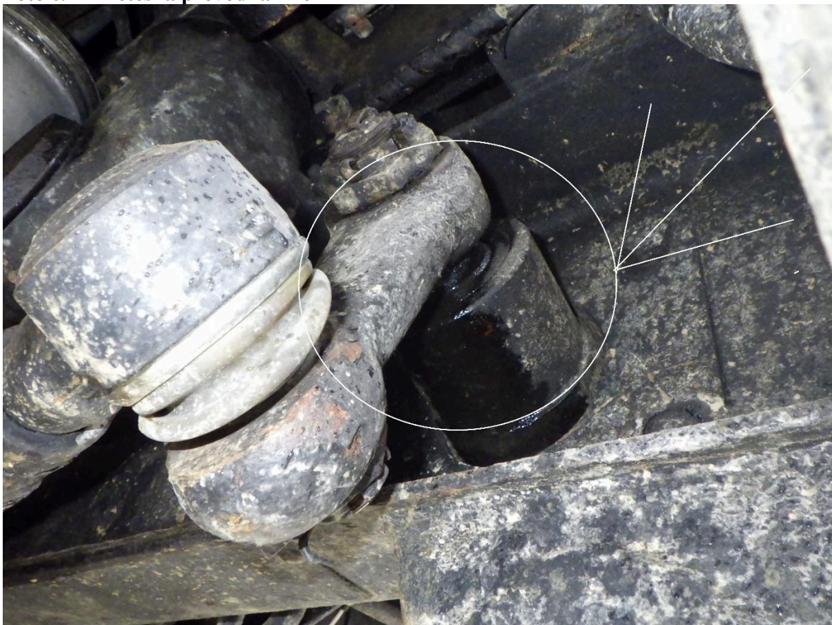
Foto č. 4 – netěsná převodka řízení
