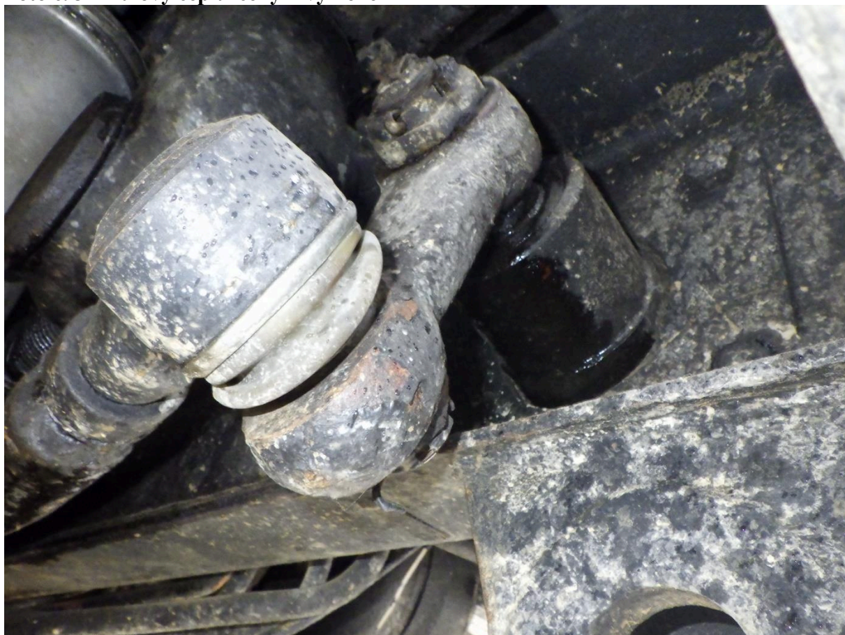
Foto č. 3 – kulový čep určený k výměně
