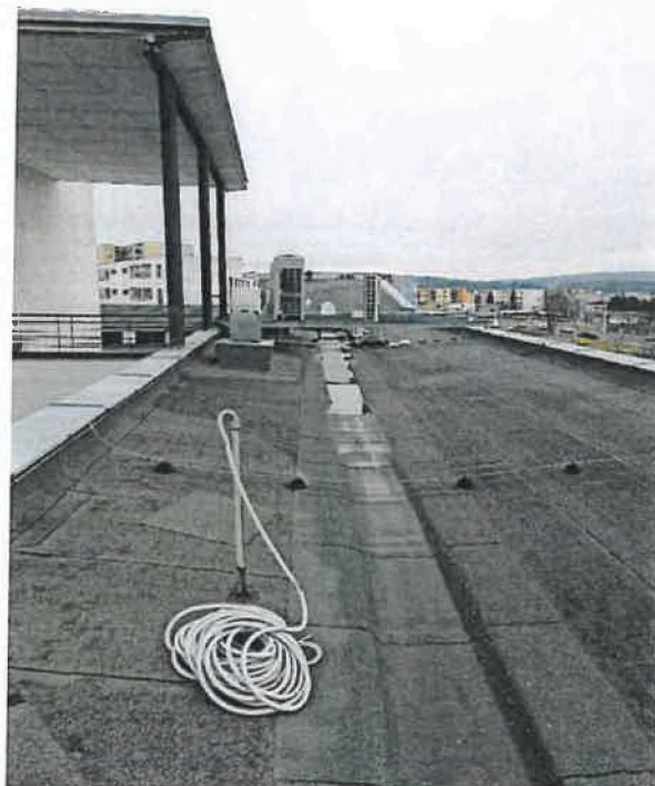
Stávající prostup střechou nad serverovnou
