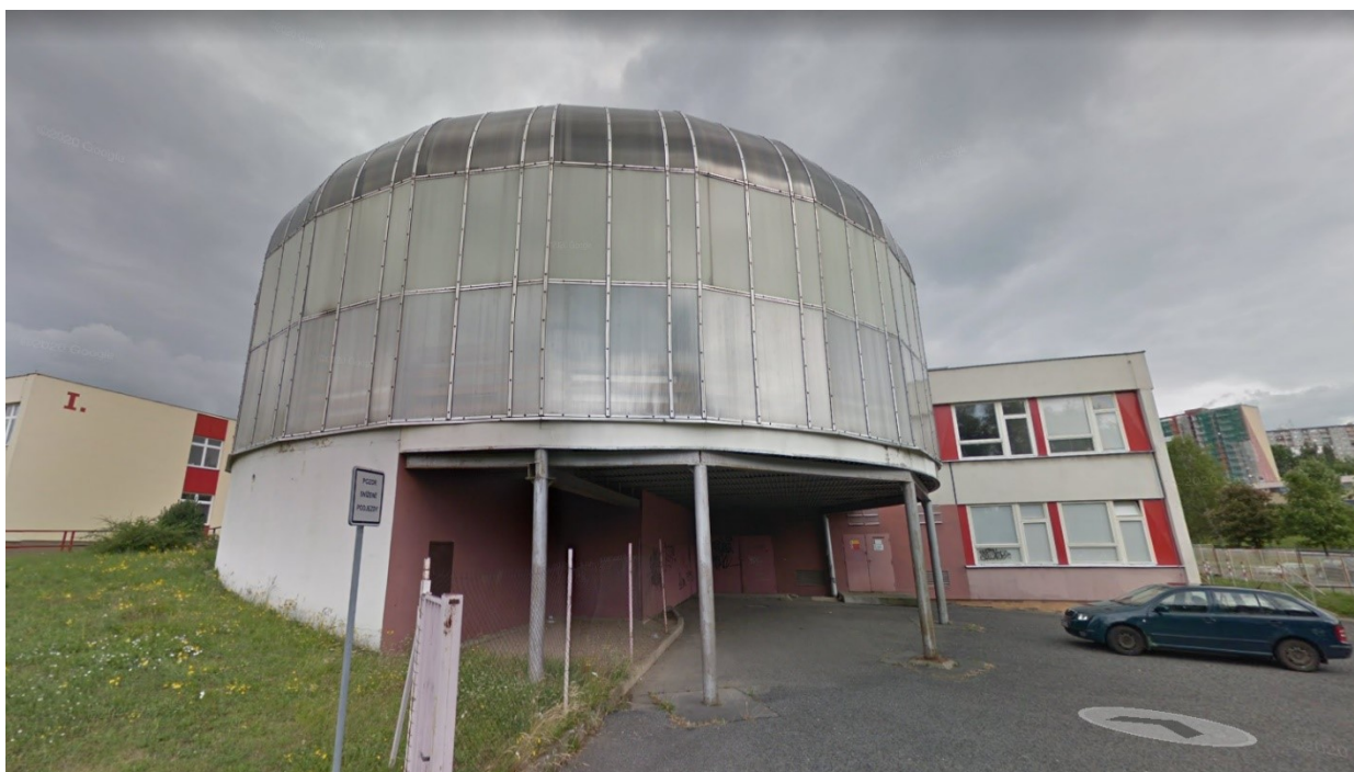
Pohled od jihu
