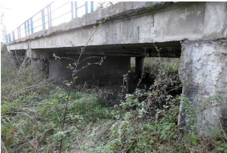
Pohled na most zprava.
