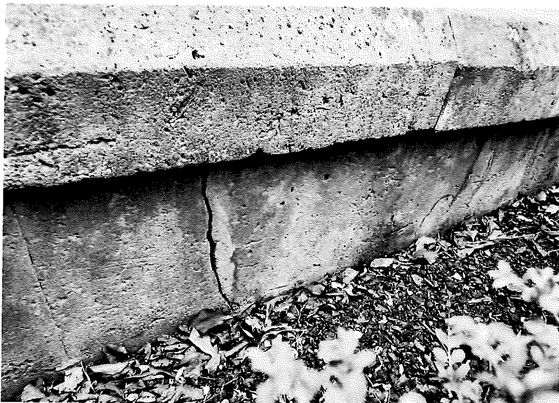
F50 – detail obložení pod obrubou rampy: povrchová koroze kamene, prasklé obložení
