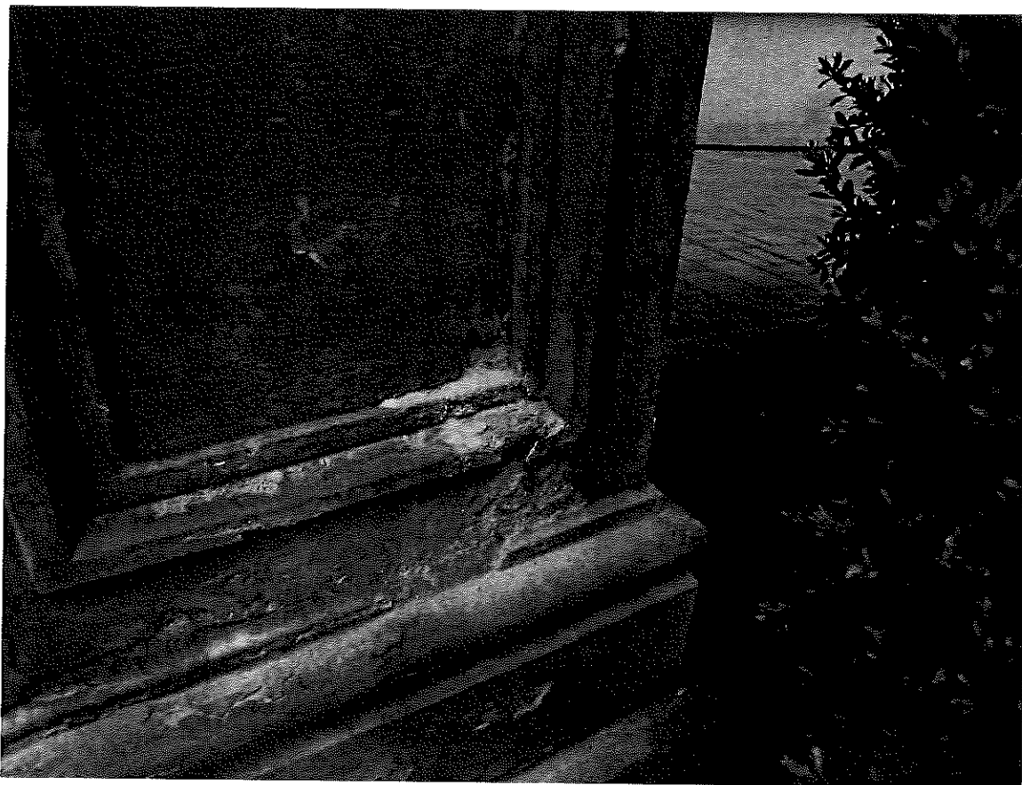
F6 – detail koroze kamene pod tmely na sloupku V pravo
