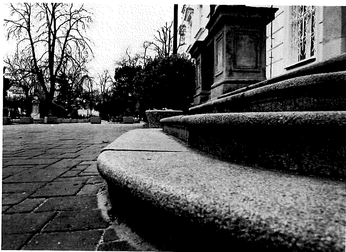
F50 – detail obložení pod obrubou rampy: povrchová koroze kamene, prasklé obložení
