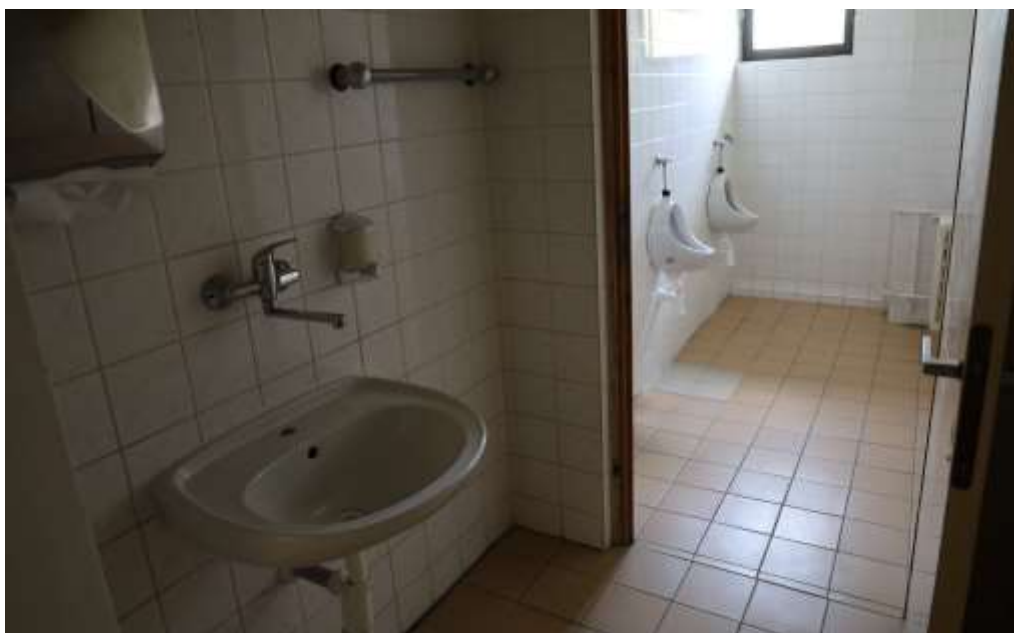
Stávající interiér toalet
