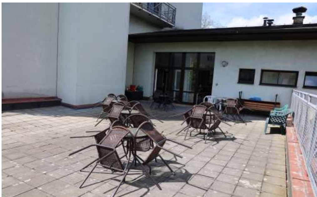
Stávající venkovní terasa
