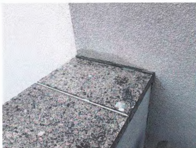
foto /27/ Detail ukončení zábradlí u severní fasády
