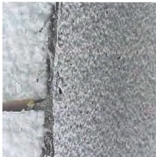
foto /13/ Volná spára mezi EPS deskami, u vnějšího foto /14/ Detail z foto /13/ líce vyplněná částečně stěrkovou hmotou
