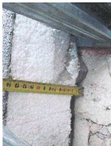
foto /15/ Lepidlo tl. 20 mm, EPS tl. 120 mm, základní vrstva tl. 1 mm
