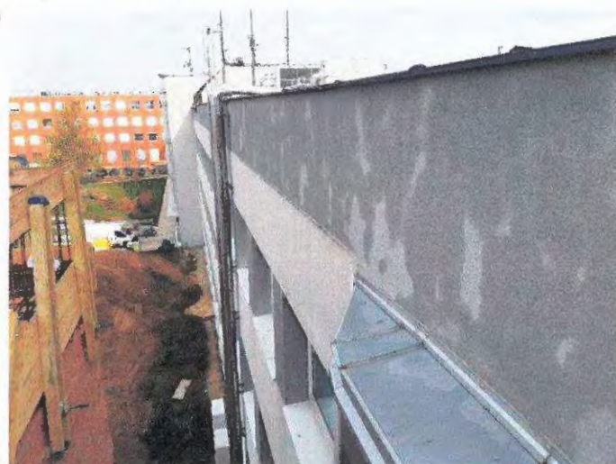
foto /9/ Atika západní fasády
