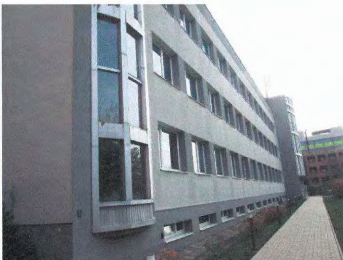
foto /6/ Západní fasáda (vlevo severozápadní nároží)
