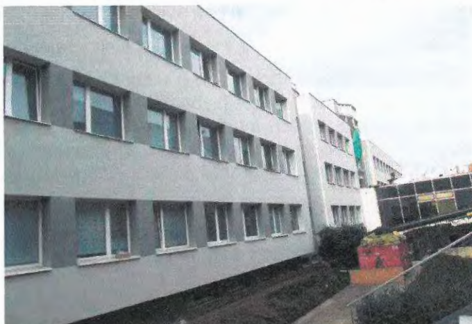
foto /3/ Východní fasáda objektu
