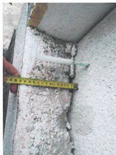
foto /36/ Základní vrstva v sondě 1 – tl. 1 mm
