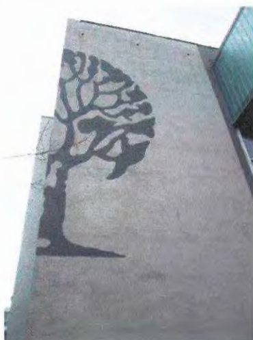
foto /7/ Severní štít
