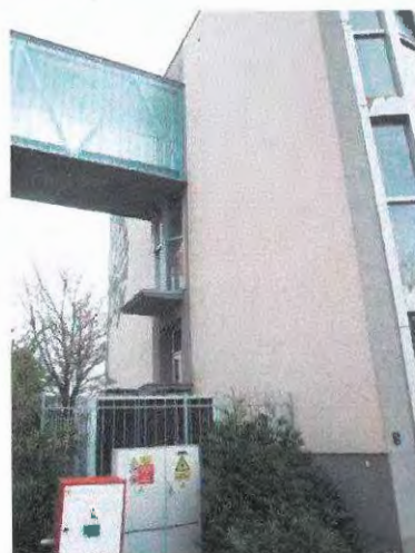
foto /8/ Severní štít
