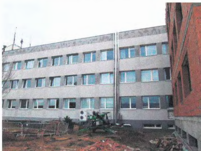
foto /5/ Západní fasáda (vpravo stavba přístavby)
