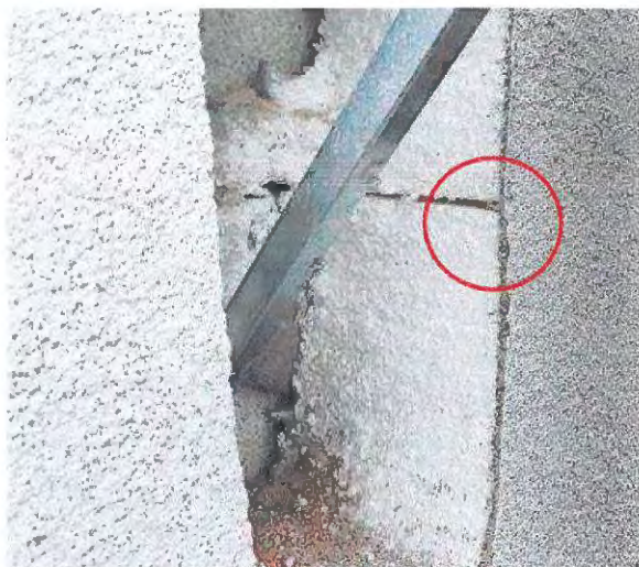
foto /13/ Volná spára mezi EPS deskami, u vnějšího foto /14/ Detail z foto /13/ líce vyplněná částečně stěrkovou hmotou
