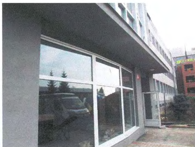
foto /17/ Zastřešení nad západním vstupem
