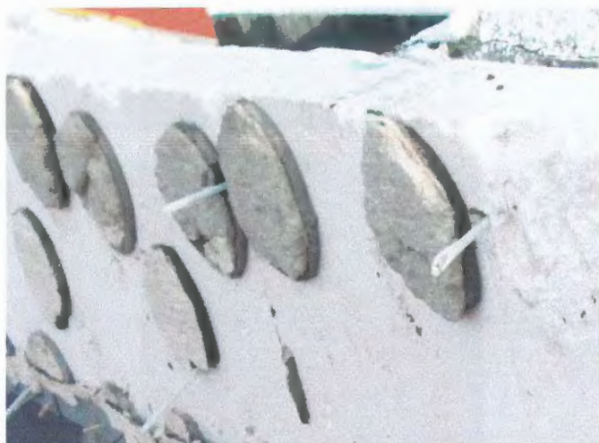
foto /31/ Detail kotev systému
