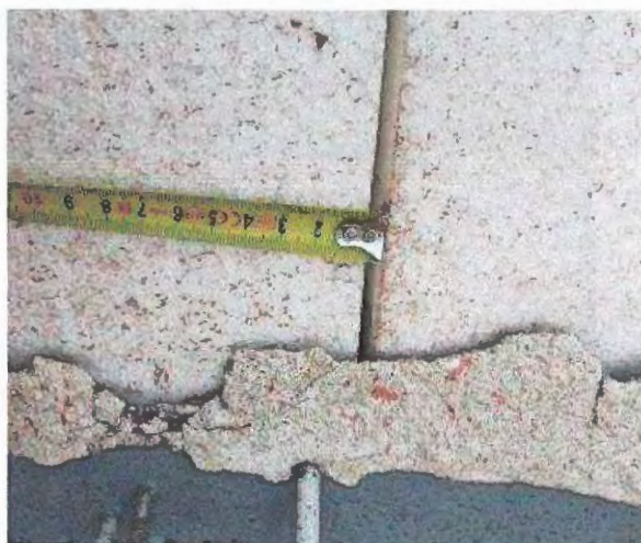
foto /32/ Mezera mezi deskami EPS 6 mm
