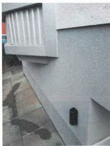
foto /23/ Napojení ETICS na lehký obvodový plášť (LOP)
