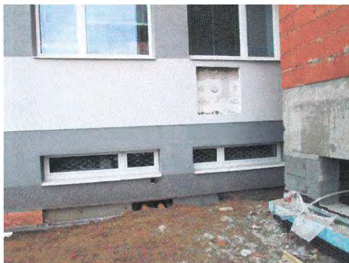
foto /16/ Místo sondy S2 z provádění zkoušky přidrženosti lepidla ([5] )
