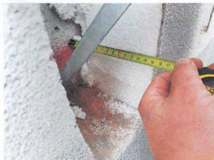
foto /11/ Sonda v místě kotvení nového komínu
