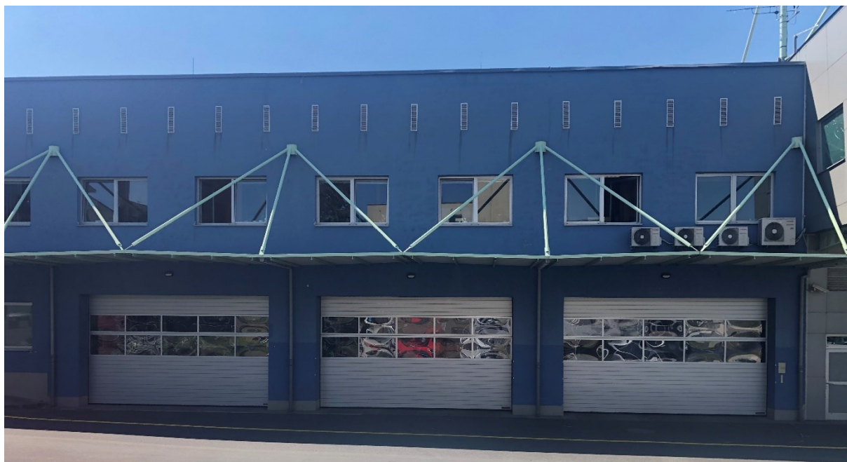
VZ Ústí nad Labem – hlavní budova současný stav
