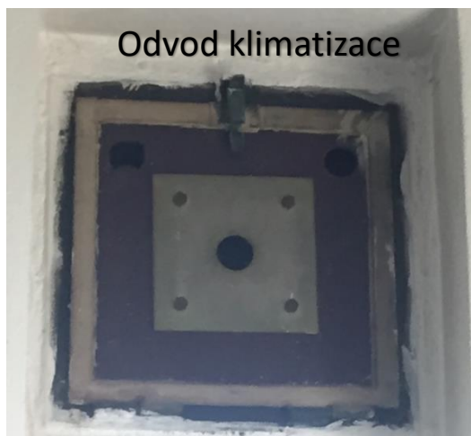
Obr. 6 Průchod k odvodu odkapu klimatizace
