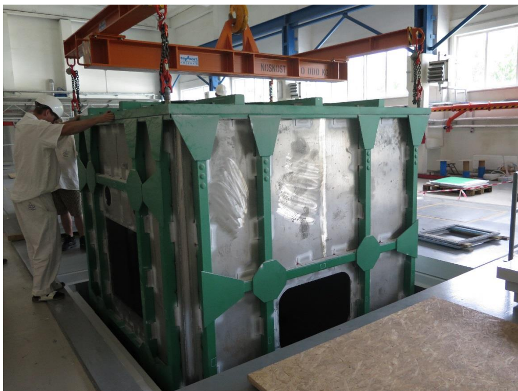
Foto č. 1: Zasouvání boxu do kobky
