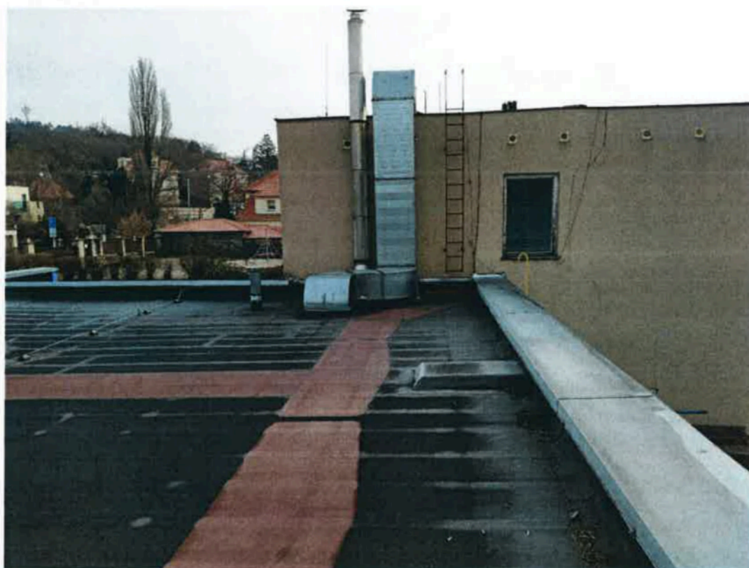
Střecha zrekonstruovaného hospodářského objektu
