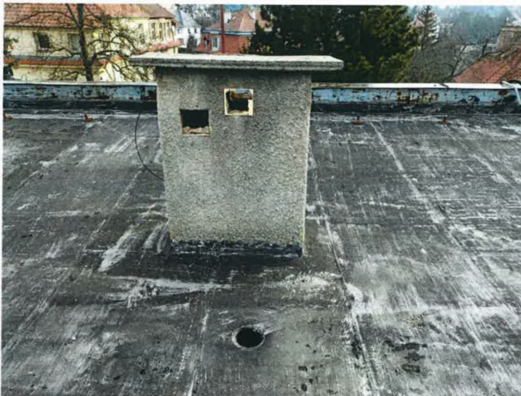
Stav střešních komínků
