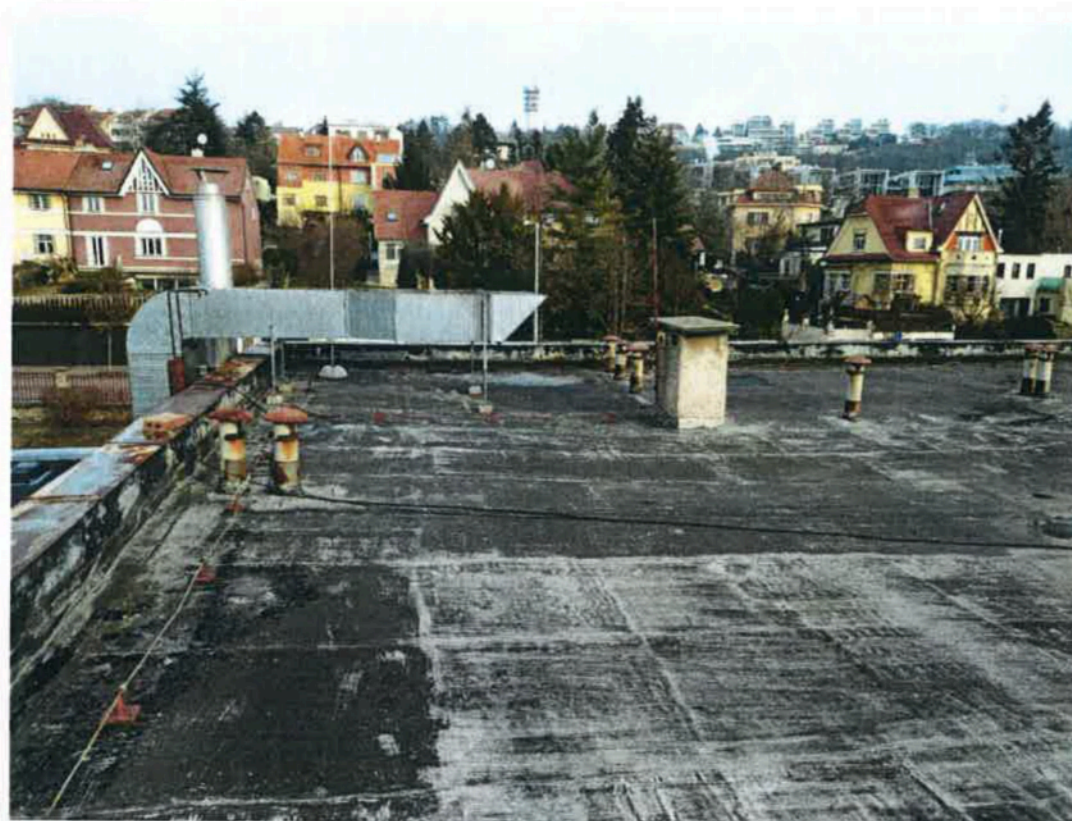
Střecha objektu s třídami
