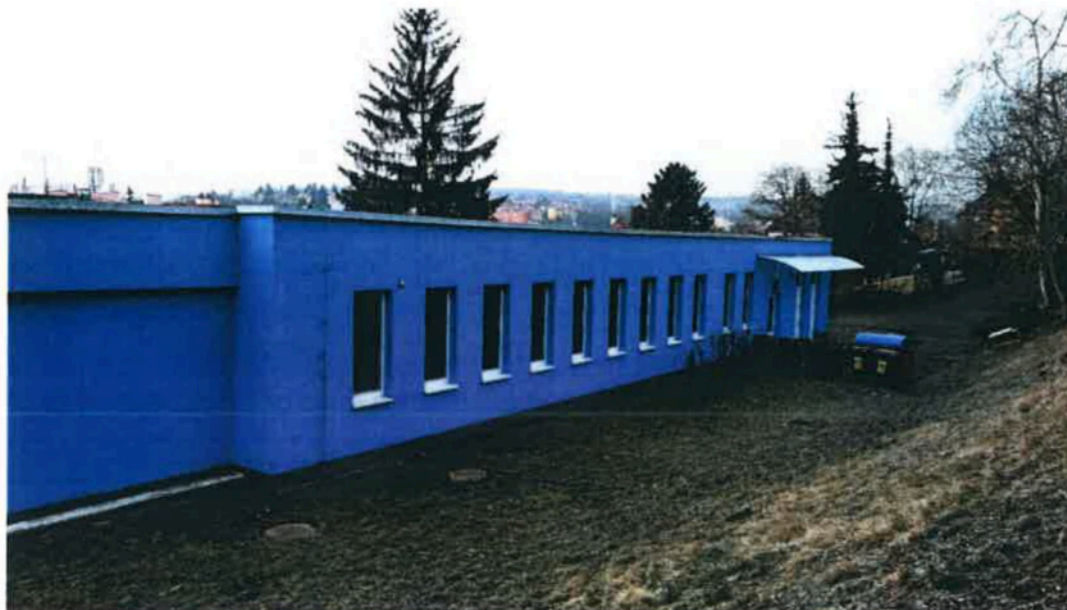
Pohled na severní fasádu hospodářského objektu
