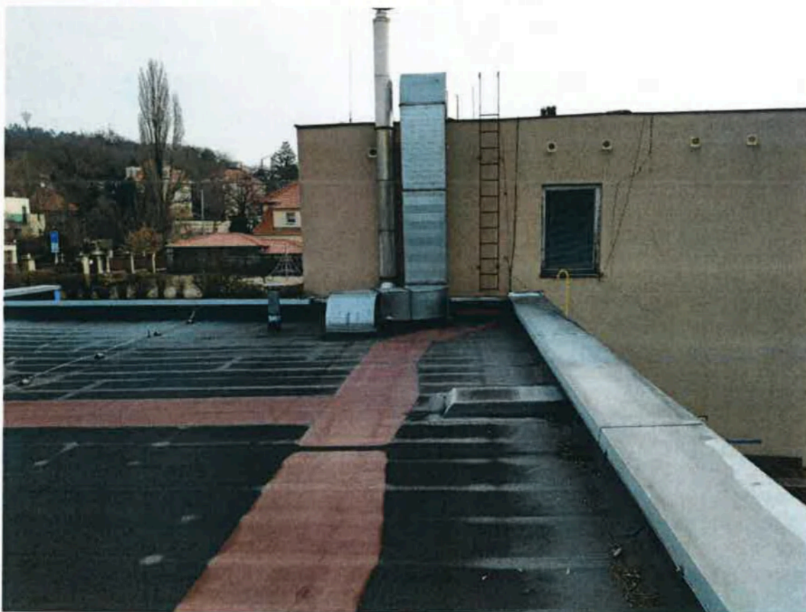
Obrázek 4 – Nová střecha + nutná přeložka komínu a vzduchotechniky:
