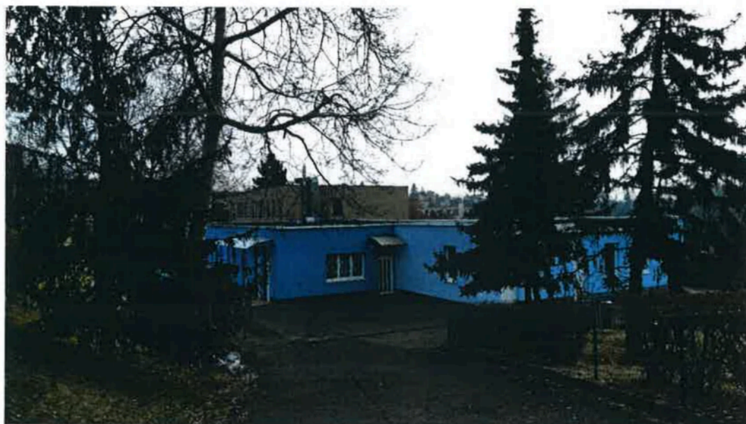
Pohled od zásobovacího vjezdu
