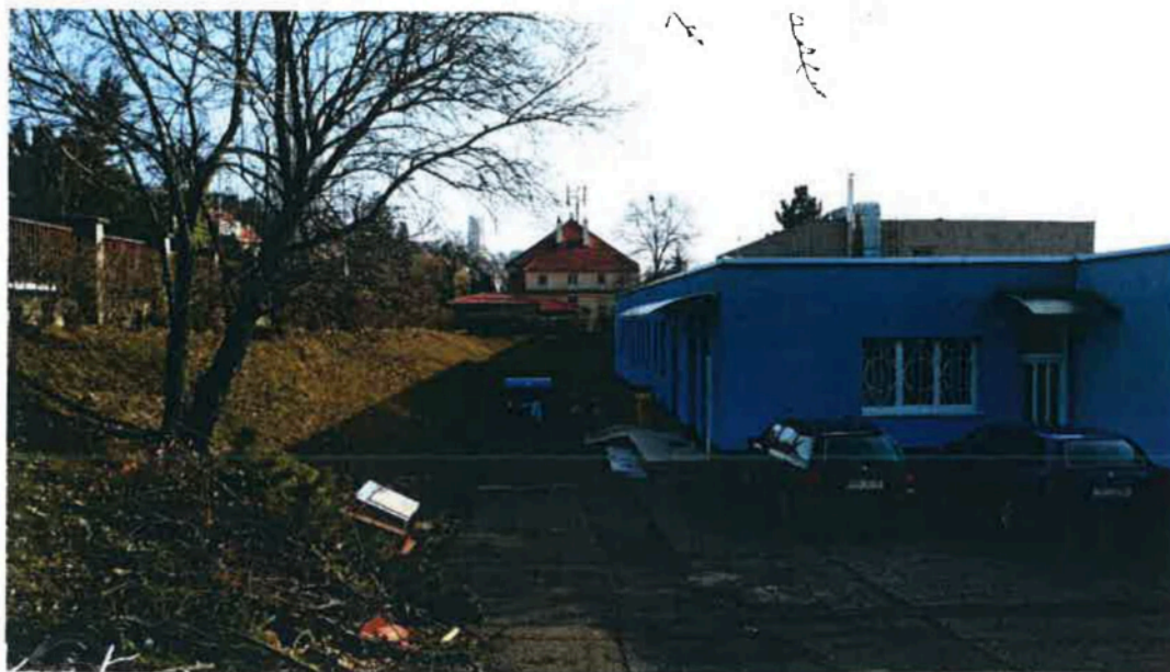
Pohled na prostor zásobování kuchyně
