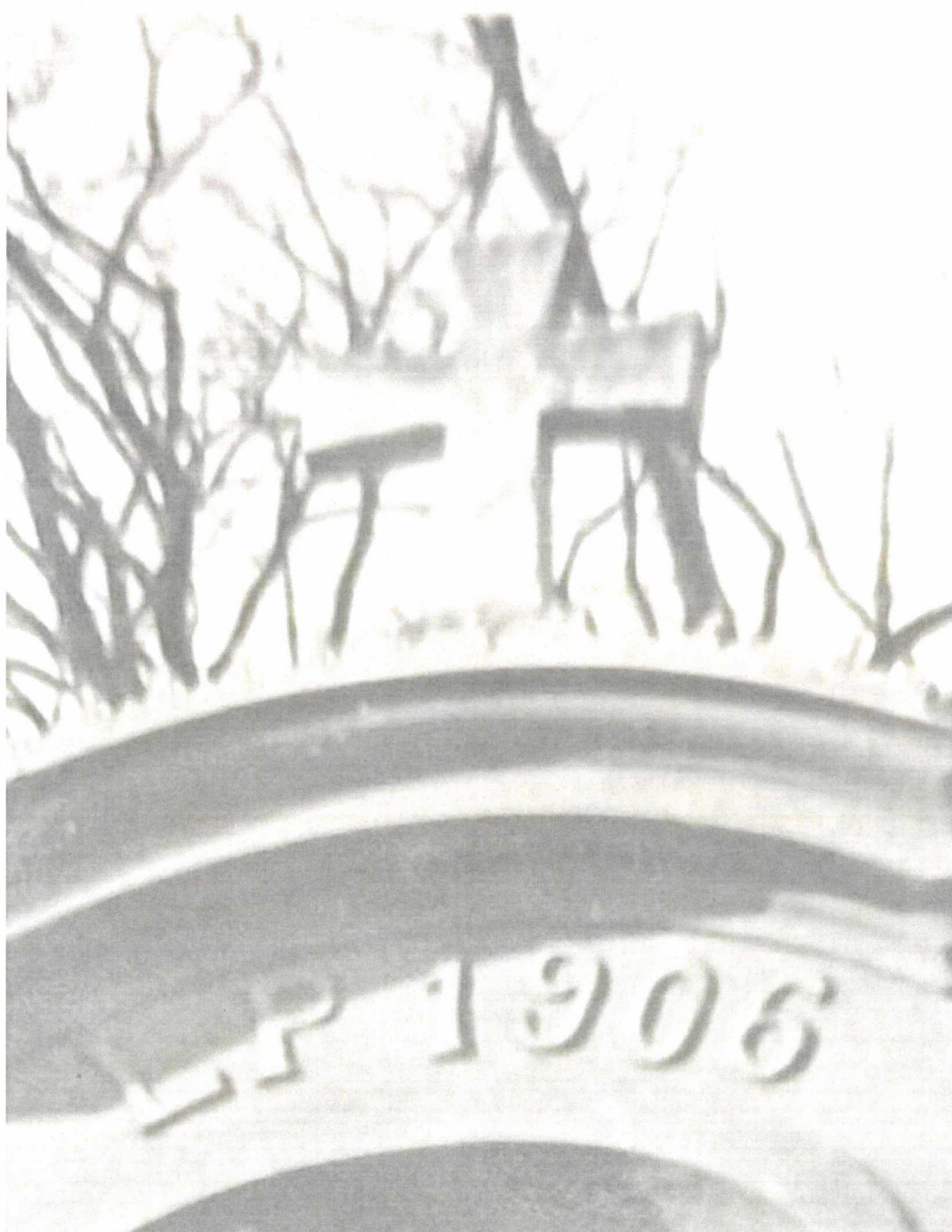
Detail kamenného kříže na atice průčelí schodiště.
