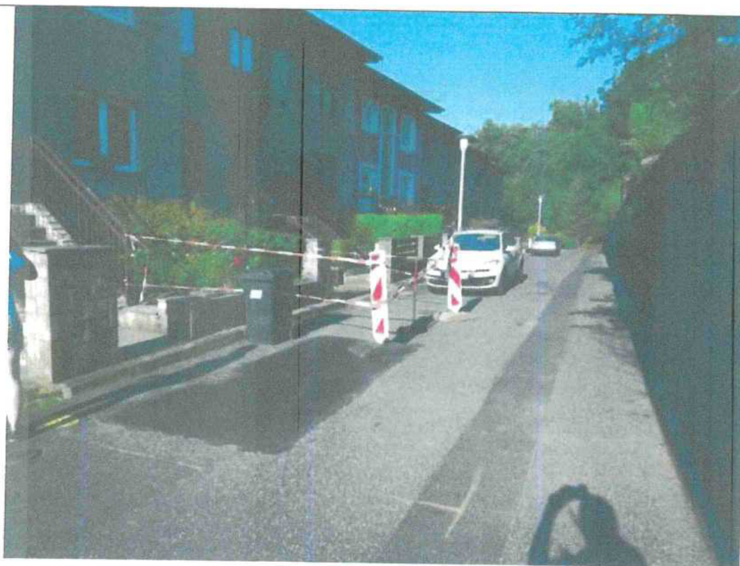
Obr. 01 Celkový pohled na místo propadu od východu k západu, trasírka v propadu
