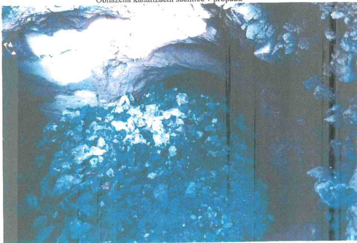
Obnažená kanalizační šachtice v propadu
