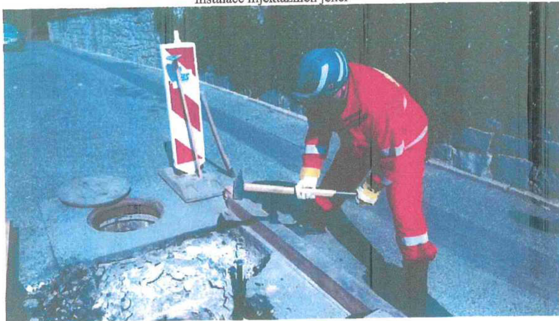
Instalace injektážních jehel
