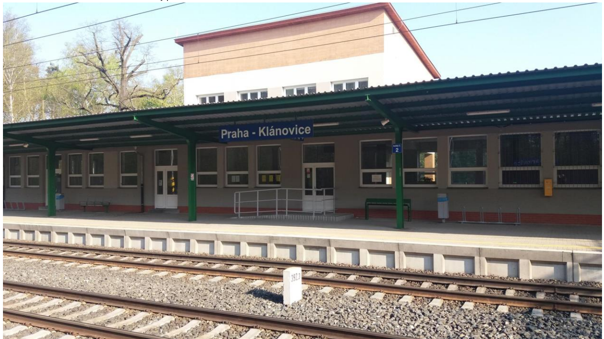
Železniční zastávka - dnešní výpravní budova
