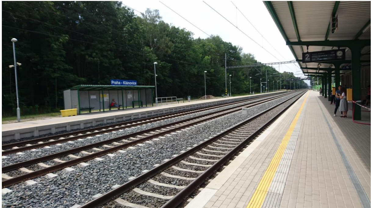
Železniční zastávka - dnešní přístřešky
