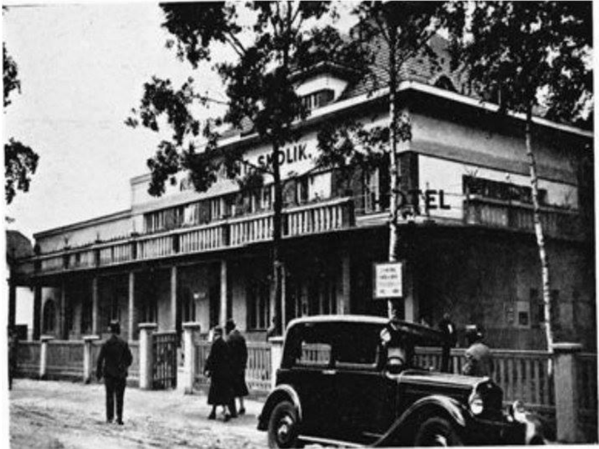
Restaurant a hotel Smolík (jižní strana)
