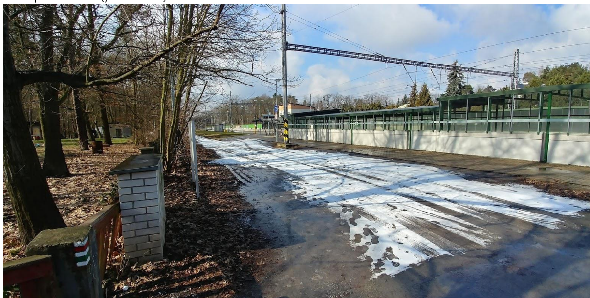
Přístup k zastávce (jižní strana)
