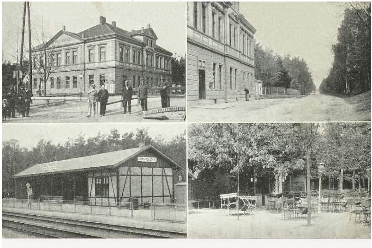
Restaurant Dasch a železniční zastávka (severní strana)
