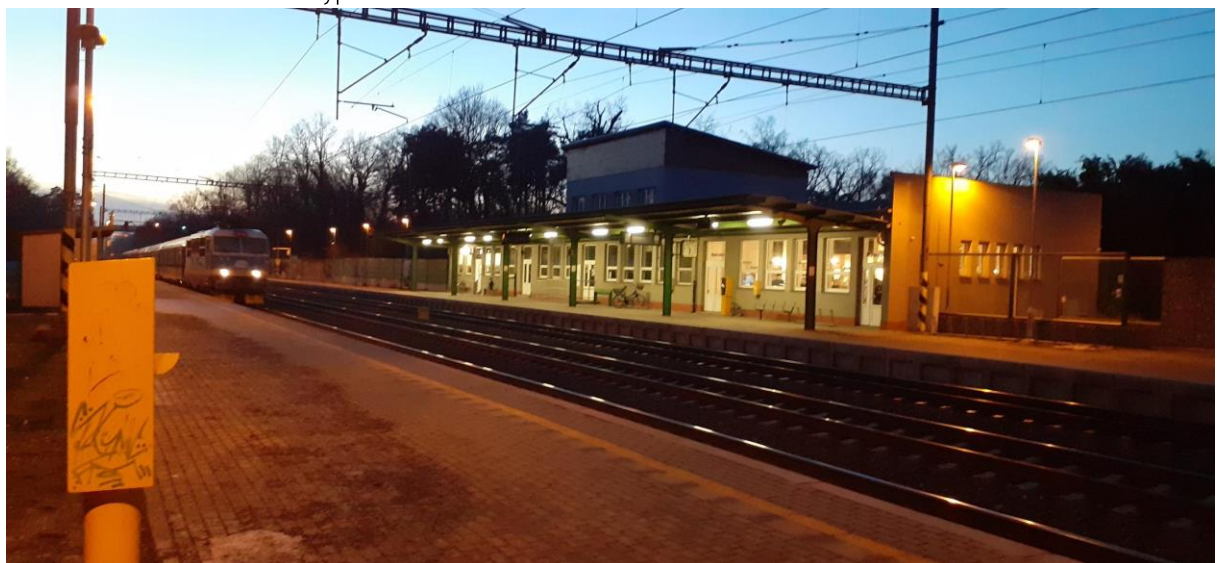
Železniční zastávka - dnešní výpravní budova
