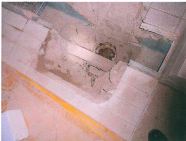
Obr. 34 Dtto jako předchozí obrázek, pouze detailní pohled do bývalé vpusti bez izolace.
