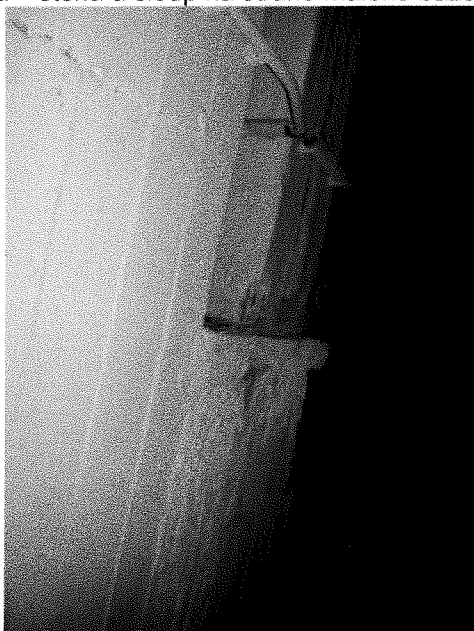
Obr. 17 Dtto – detail římsy sloupu
