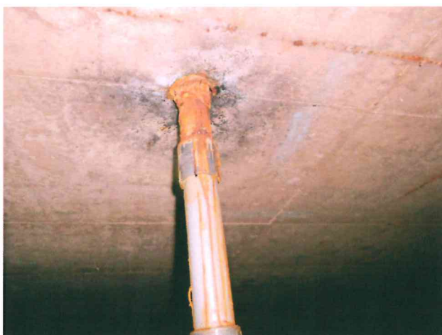
Obr. 23 Dtto – příklad tekoucí průchodky.
