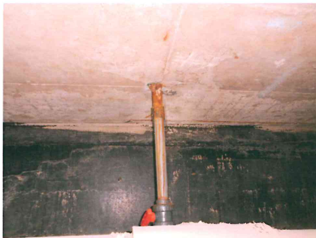
Obr. 25, Dtto porucha těsnosti průchodu žb deskou, zajímavě izolovaná stěna penetračním nátěrem.
