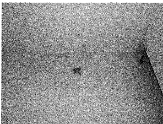
Obr. 38 Sprchy u šaten . jedna z vpustí, které způsobují protečení o podlaží níže, obr. č. 18, 19, a 27 – 30.
