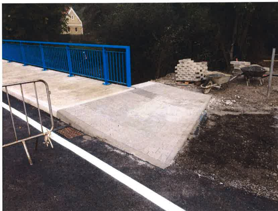
Foto č. 12 – Signální pás z reliéfní dlažby šedé barvy za mostem
