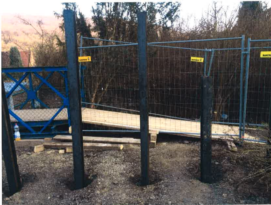
Foto č. 5 – Zápory z ocelových profilů HEB 120 vložené do vrtů
