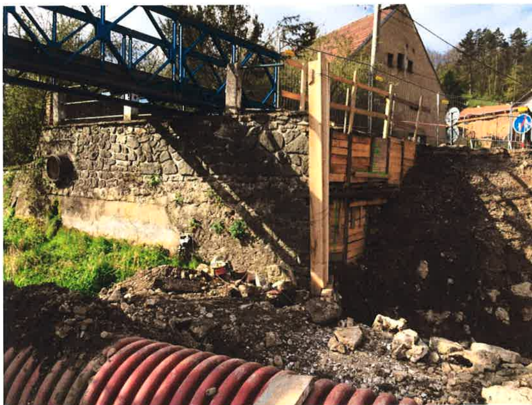
Foto č. 10 – Dokončená pažící stěna u OP1
