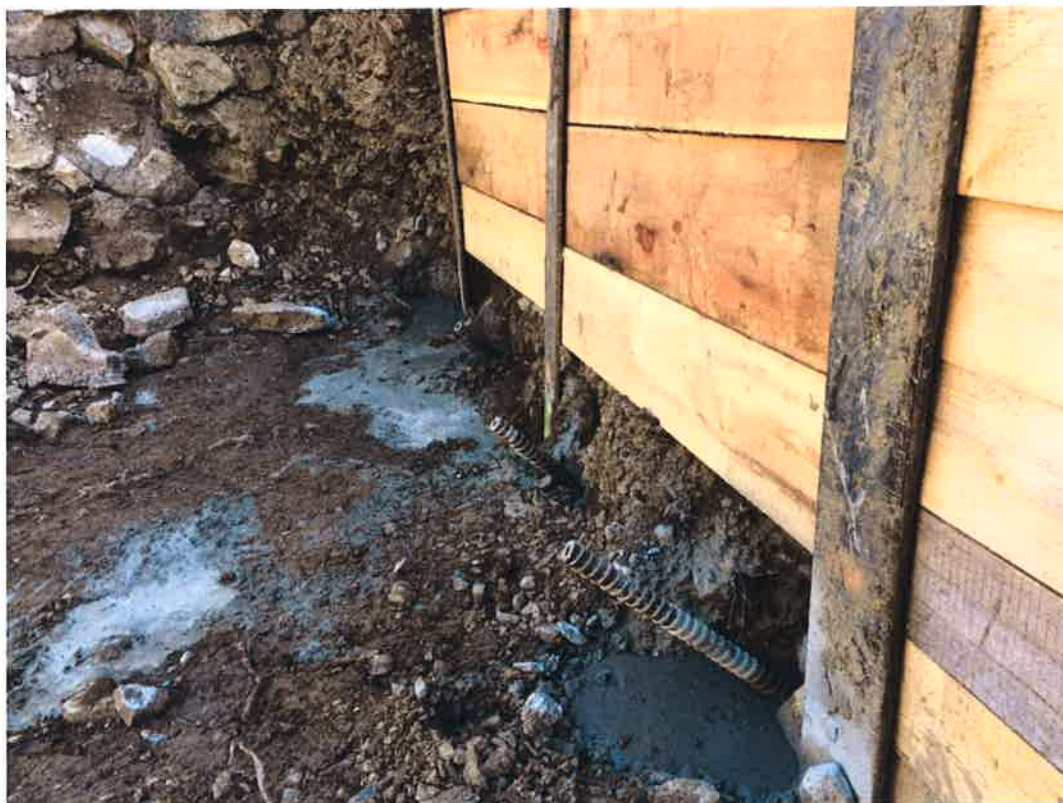
Foto č. 7 – Detail zemních kotev záporové pažící stěny
