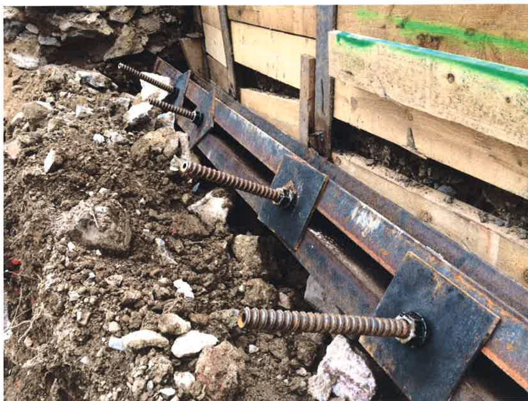
Foto č. 8 – Detail aktivovaných zemních kotev a převázky z ocelových profilů 2x U200
