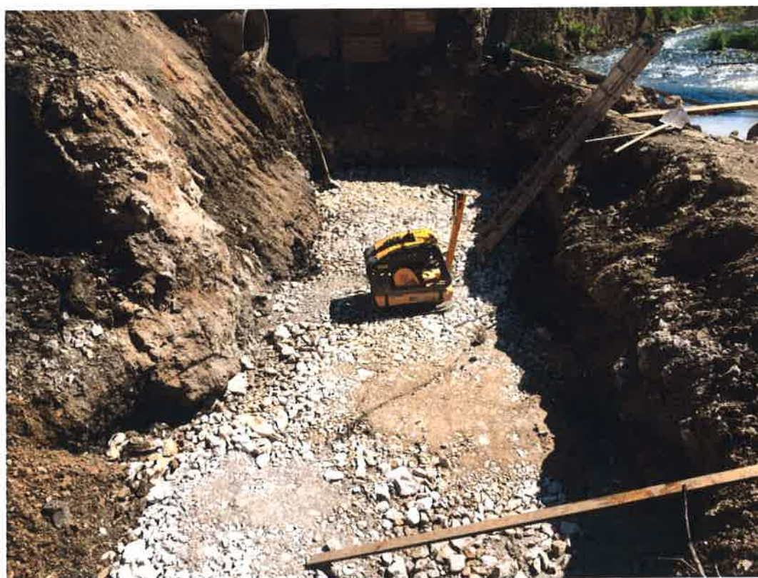
Foto č. 4 – Dokončený sanační polštář základové spáry OP2
