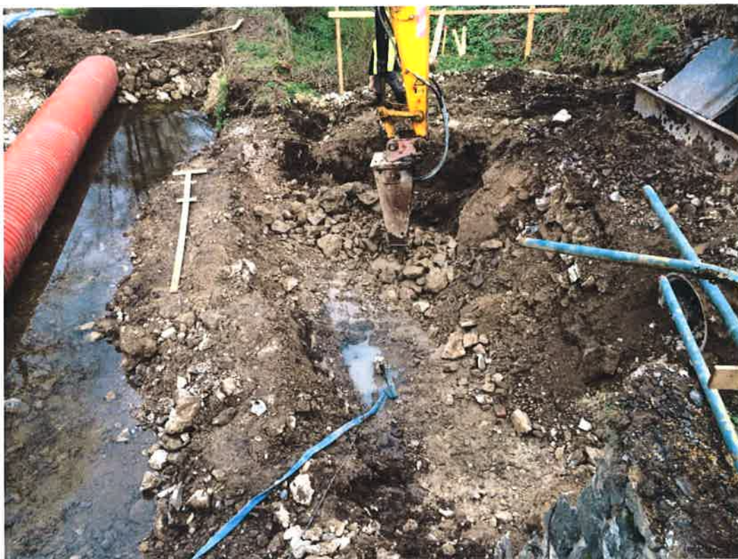
Foto č. 1 – Hloubení základu OP2.
