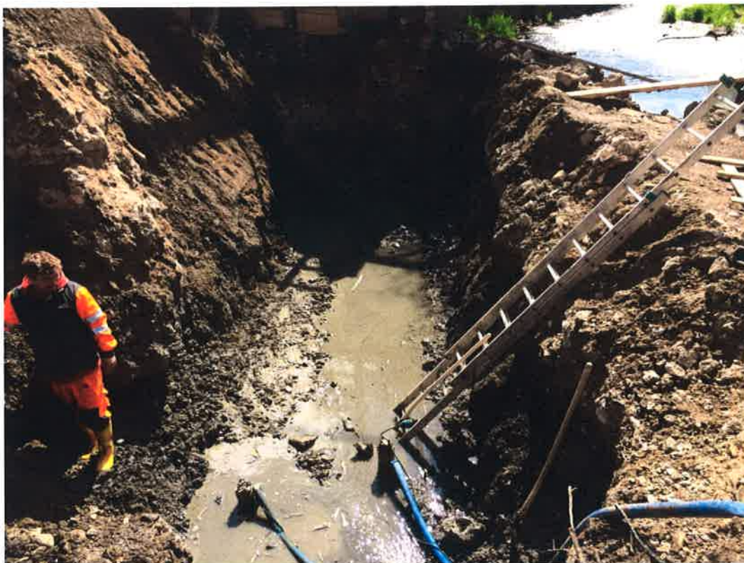
Foto č. 3 – Základová spára OP2, stav před provedením sanačního polštáře
