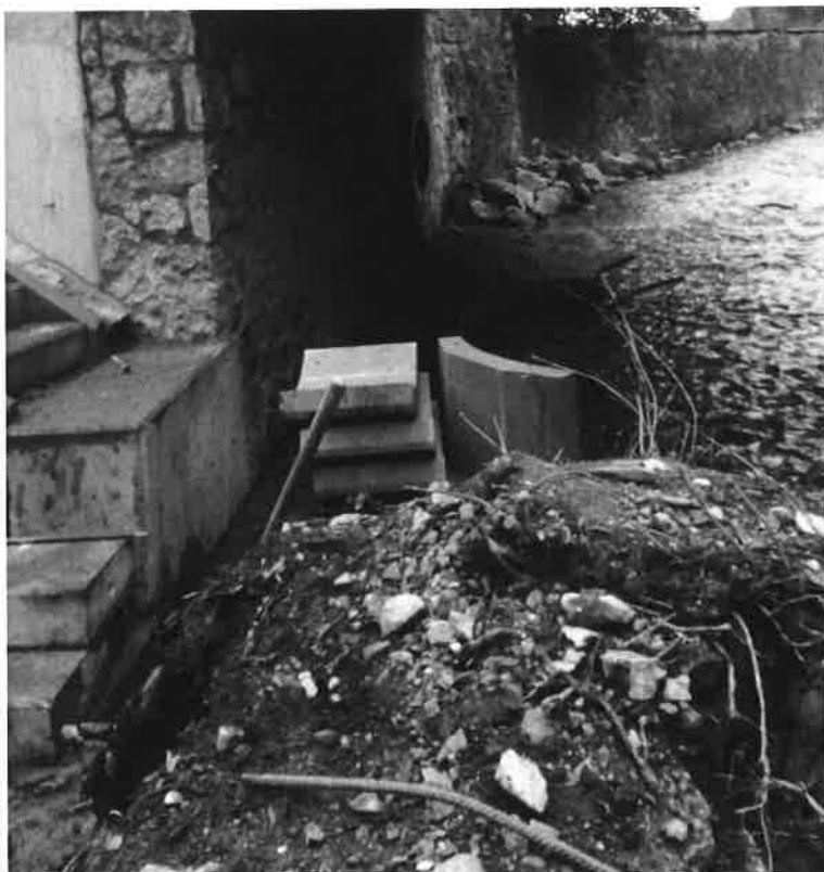
Foto č. 17 – Podezdění a uložení 3 stupňů revizního schodiště
