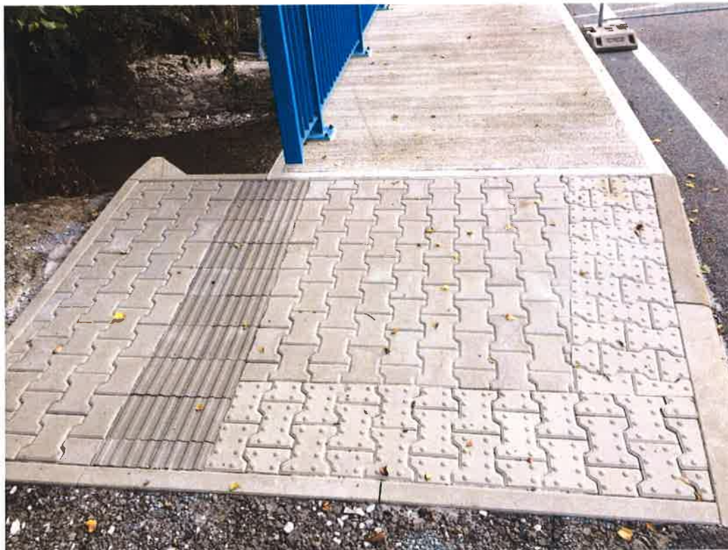
Foto č. 11 – Signální pás z reliéfní dlažby šedé barvy před mostem
