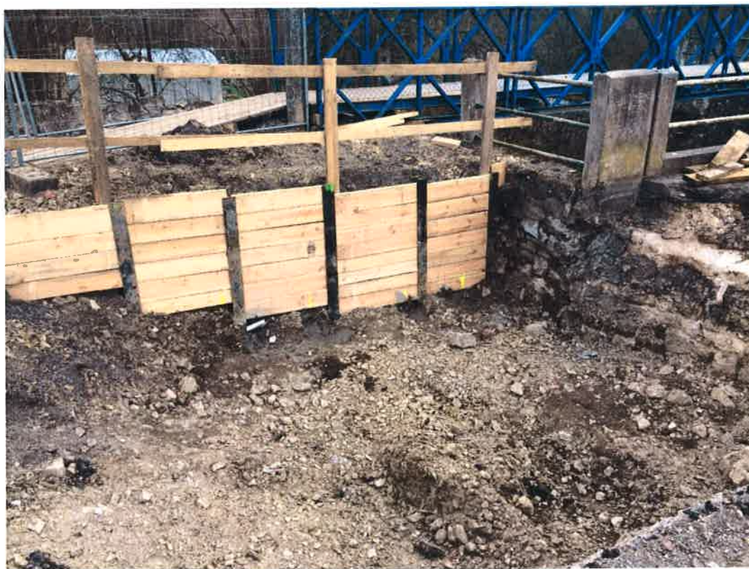
Foto č. 6 – I. Etáž záporové pažící stěny se zemními kotvami
