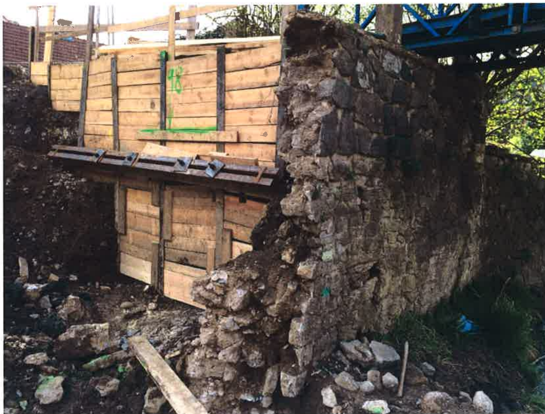
Foto č. 9 – Dokončená záporová pažící stěna u OP2
