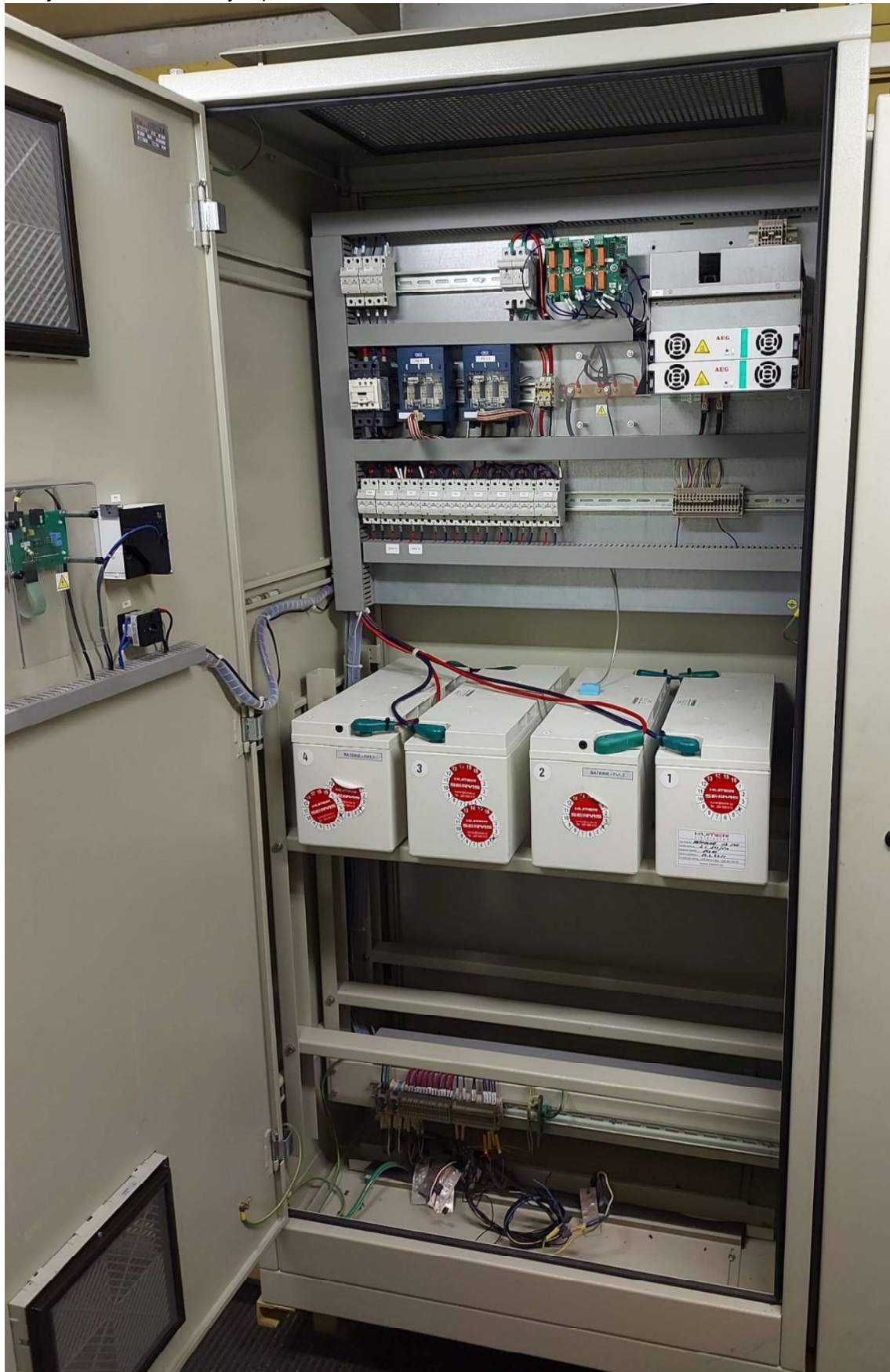
Zdroje 24 VDC linie trasy ropovodu IKL
