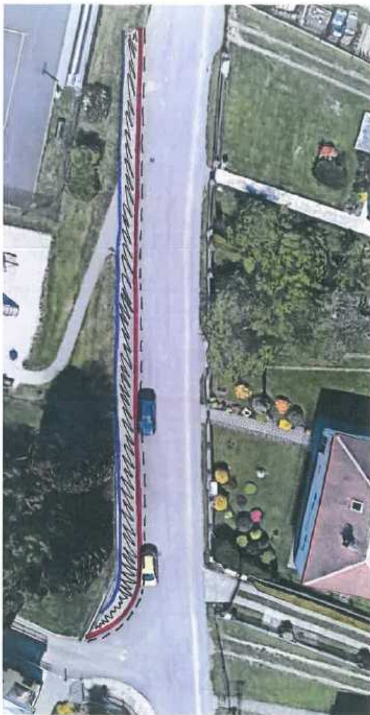
CN_08_2022_Oprava chodníku na ul. Požárnícká I. Část
